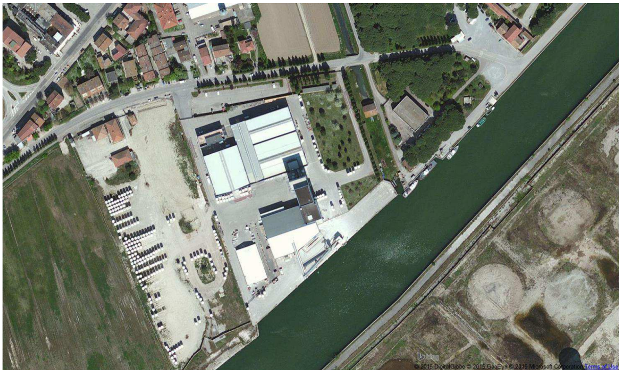
Figura 9.10. Superfici dello stabilimento di Ravenna, dall'alto.
