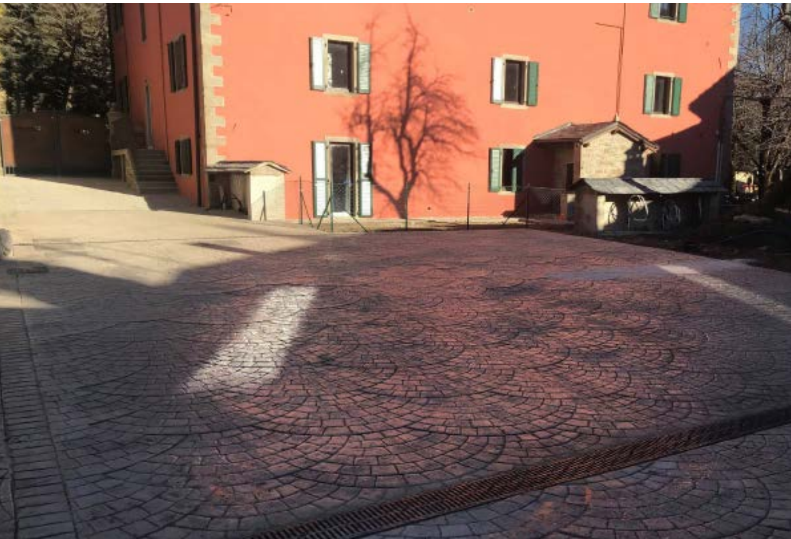
Zona parcheggio interno
