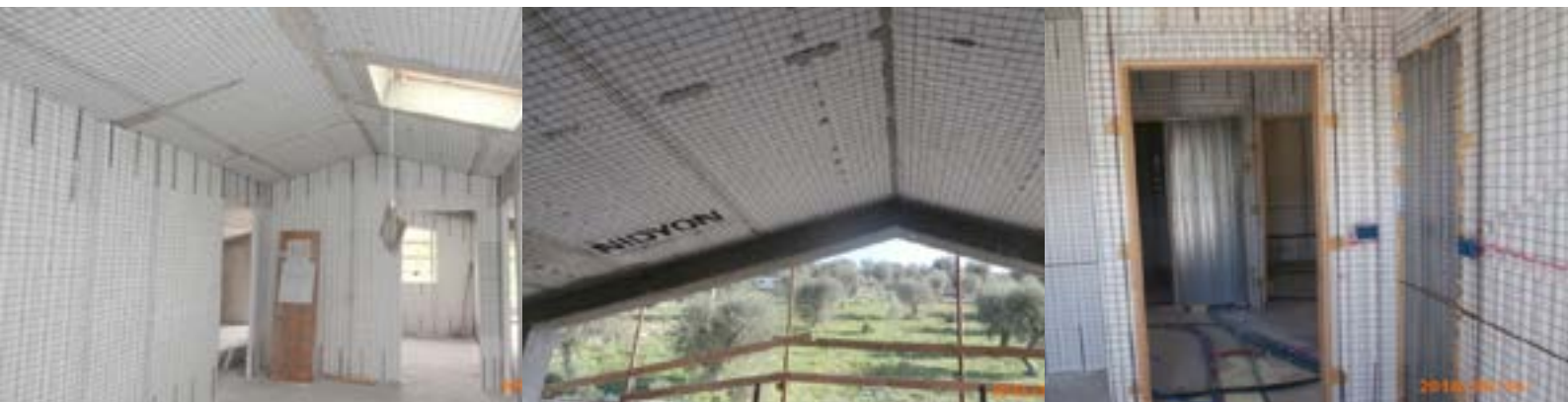
I solai in calcestruzzo armato con pannelli di polistirolo
