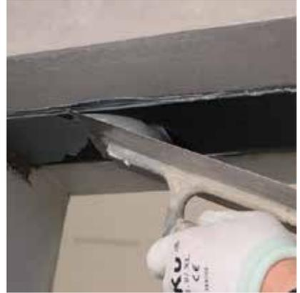
Applicare a spolvero sabbia silicea, rigorosamente asciutta, di granulometria fino a 1 mm, la quale costituirà il supporto per l'applicazione della malta. Completata la reticolazione dell'adesivo sarà possibile procedere all'applicazione della malta di finitura scelta.
