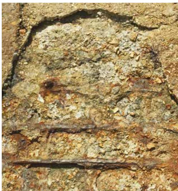
Esempio di corrosione dovuta all'attacco da cloruri.
