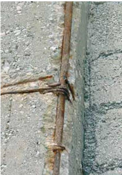
Degrado del copriferro in un pilastro in calcestruzzo.
