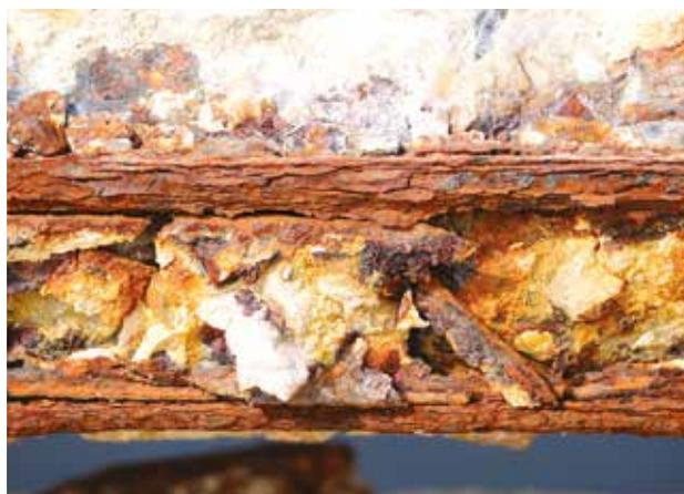
Esempio di degrado del calcestruzzo per arrugginimento dei ferri d'armatura.
