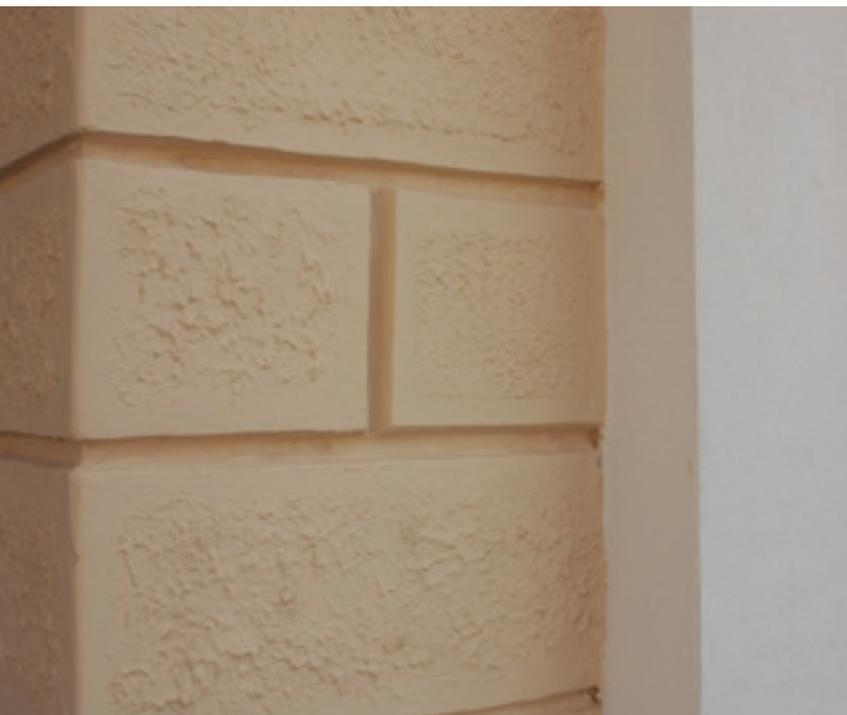
Le murature non esposte all'umidità di risalita sono state trattate con **INTONACO 700**, anche questo appartenente alla **LINEA EX NOVO RESTAURO STORICO**. Si tratta di un intonaco a base di calce idraulica naturale, polvere di marmo e sabbie calcaree classificate, utilizzabile in interventi di recupero architettonico.
