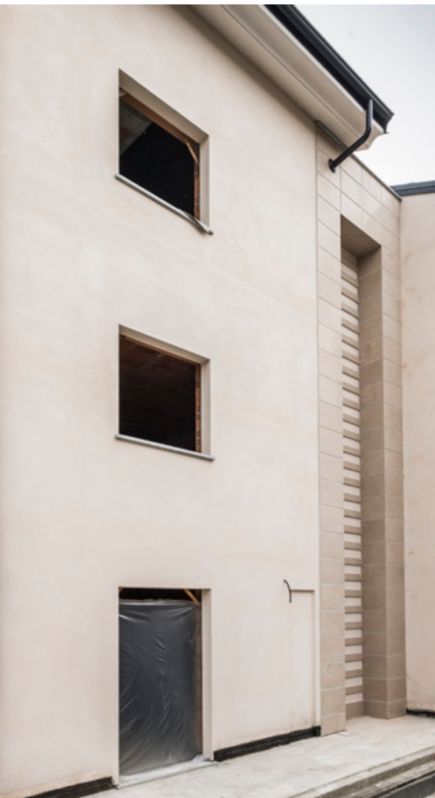
Dettaglio finiture esterne e piastrelle di marmo posate all'esterno
