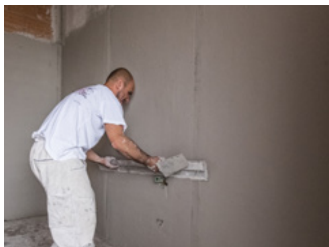
Spruzzatura e tiratura dell'intonaco
