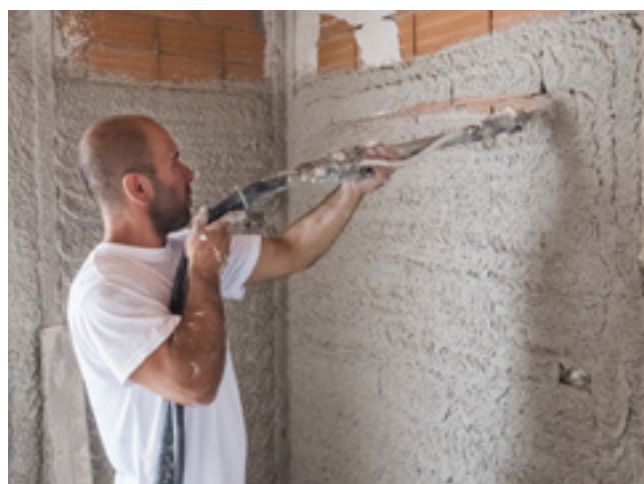
Spruzzatura e tiratura dell'intonaco
