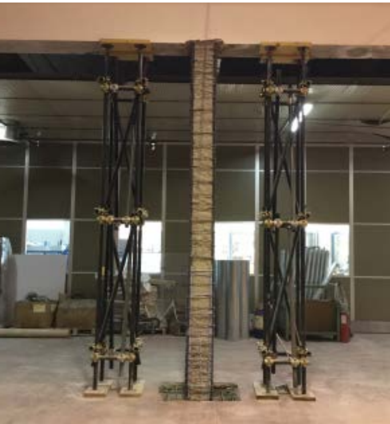
In alto a sinistra: i pilastri dopo la rimozione calcestruzzo ammalorato, in alto a destra e in basso a sinistra: cassetteria dei pilastri per il successivo getto di GEOACTIVE FLUID B 530 C, in basso a destra: i pilastri dopo l'apertura dei casseri
