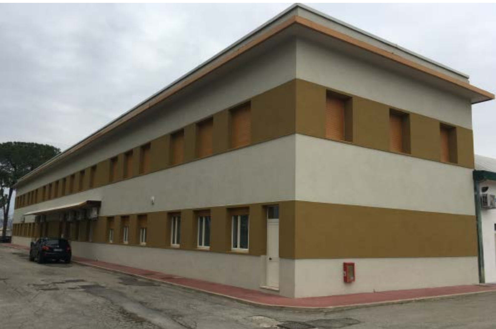
Le superfici esterne dopo la realizzazione dell'isolamento termico a cappotto
