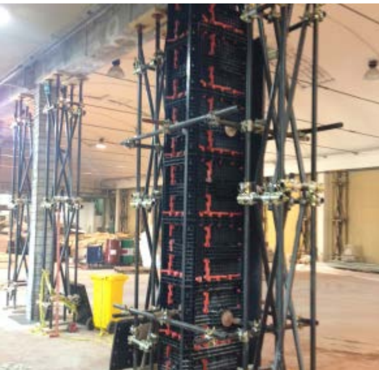
In alto a sinistra: i pilastri dopo la rimozione calcestruzzo ammalorato, in alto a destra e in basso a sinistra: cassetteria dei pilastri per il successivo getto di GEOACTIVE FLUID B 530 C, in basso a destra: i pilastri dopo l'apertura dei casseri
