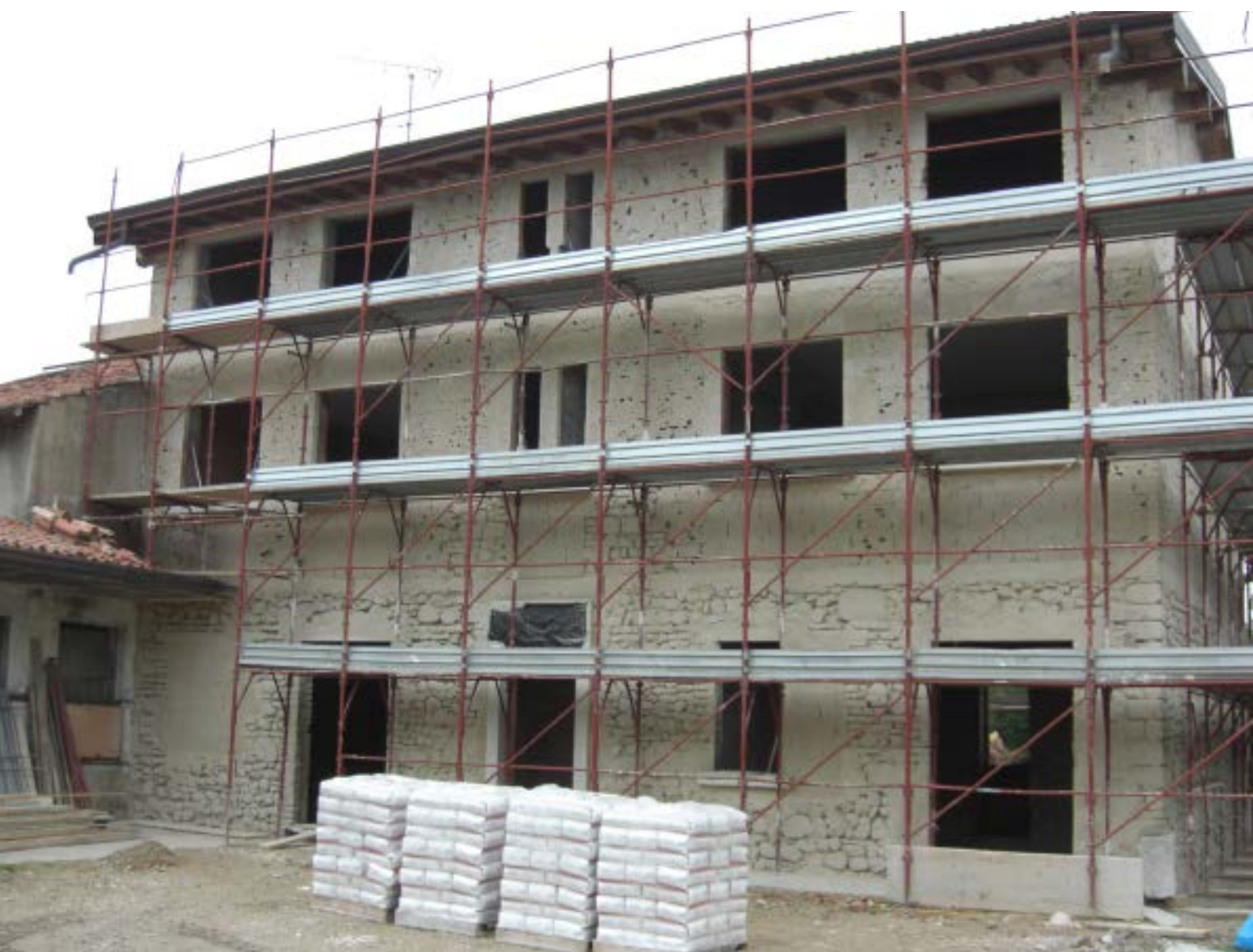
Rimozione degli intonaci esistenti
