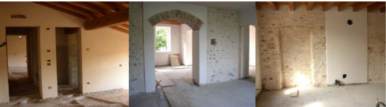
Alcune foto degli interni durante la fase di intervento
