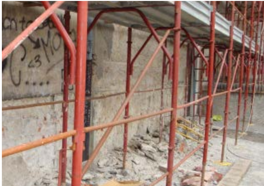
Demolizione dell'intonaco esistente
