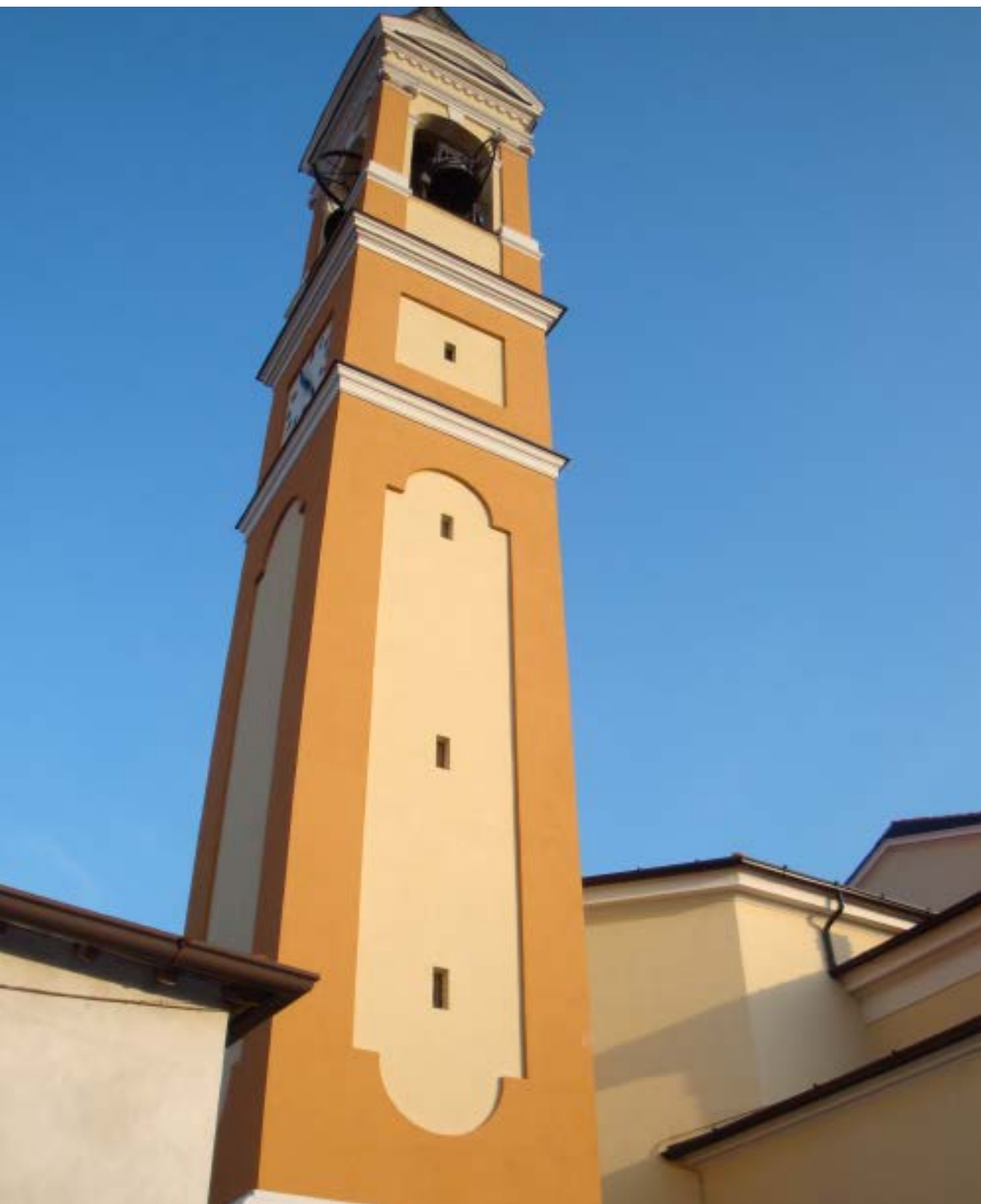
Il campanile dopo l'intervento
