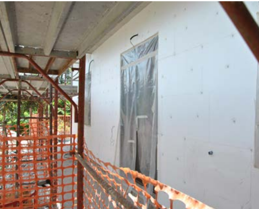
Isolamento termico a cappotto
