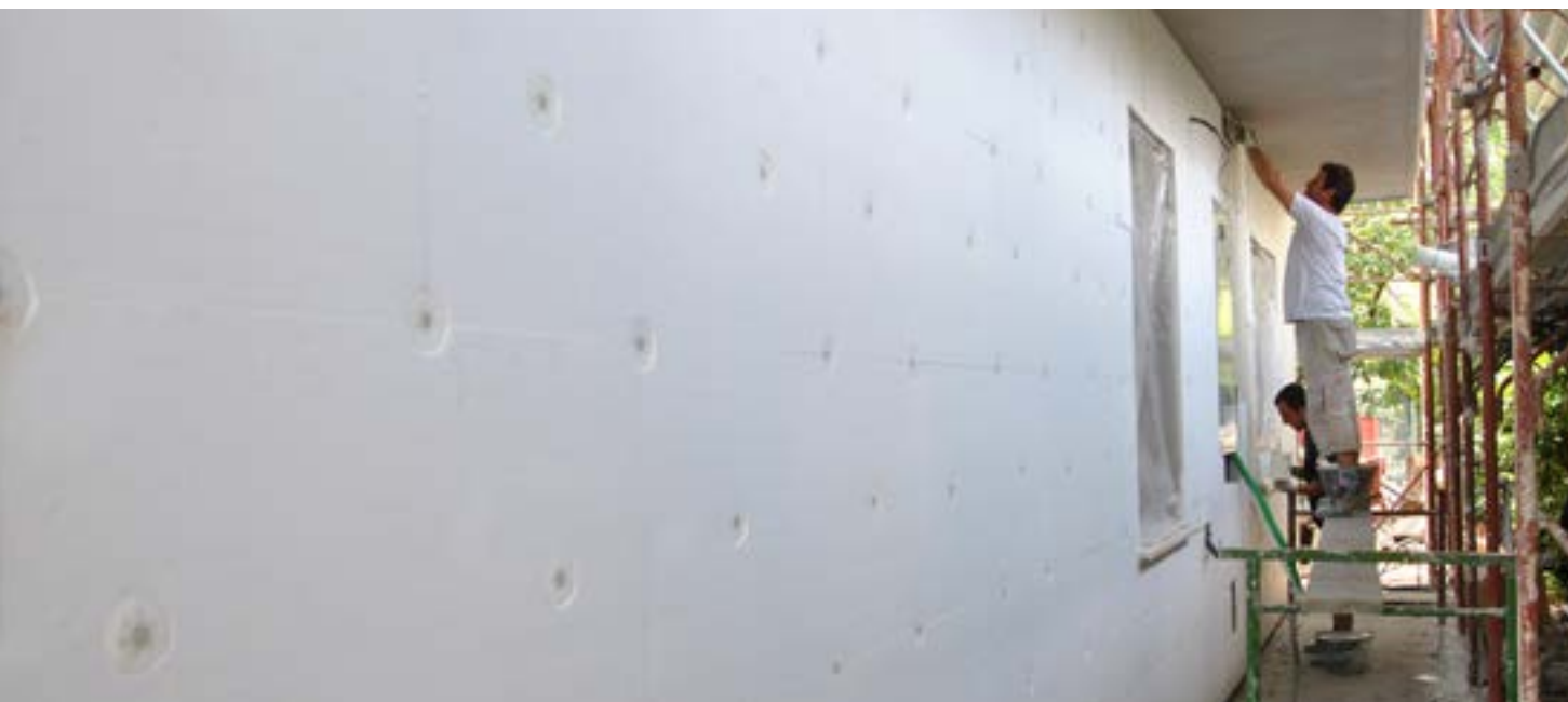
Successiva realizzazione dell'isolamento termico a cappotto
