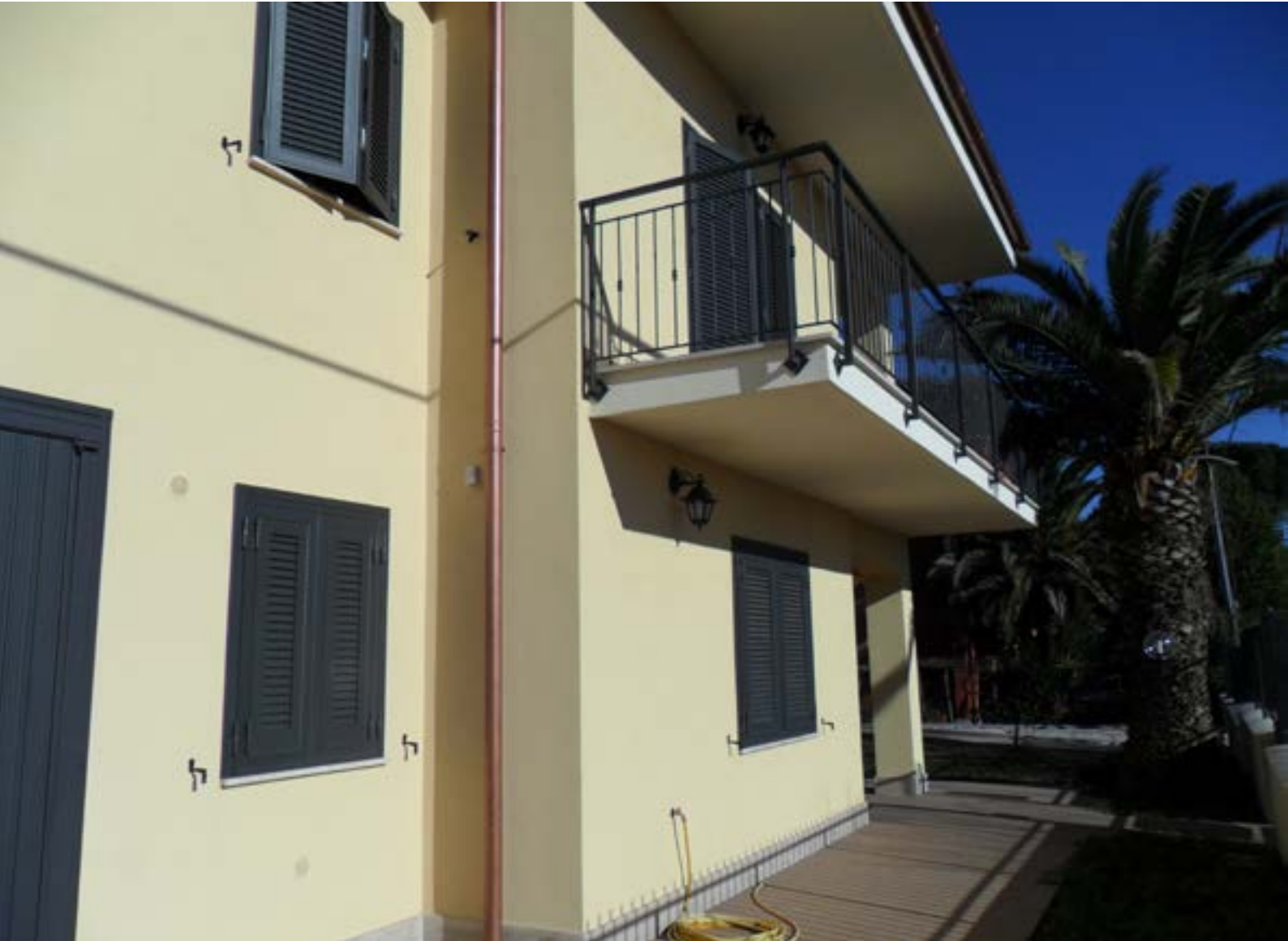
Esterni a lavoro finito
