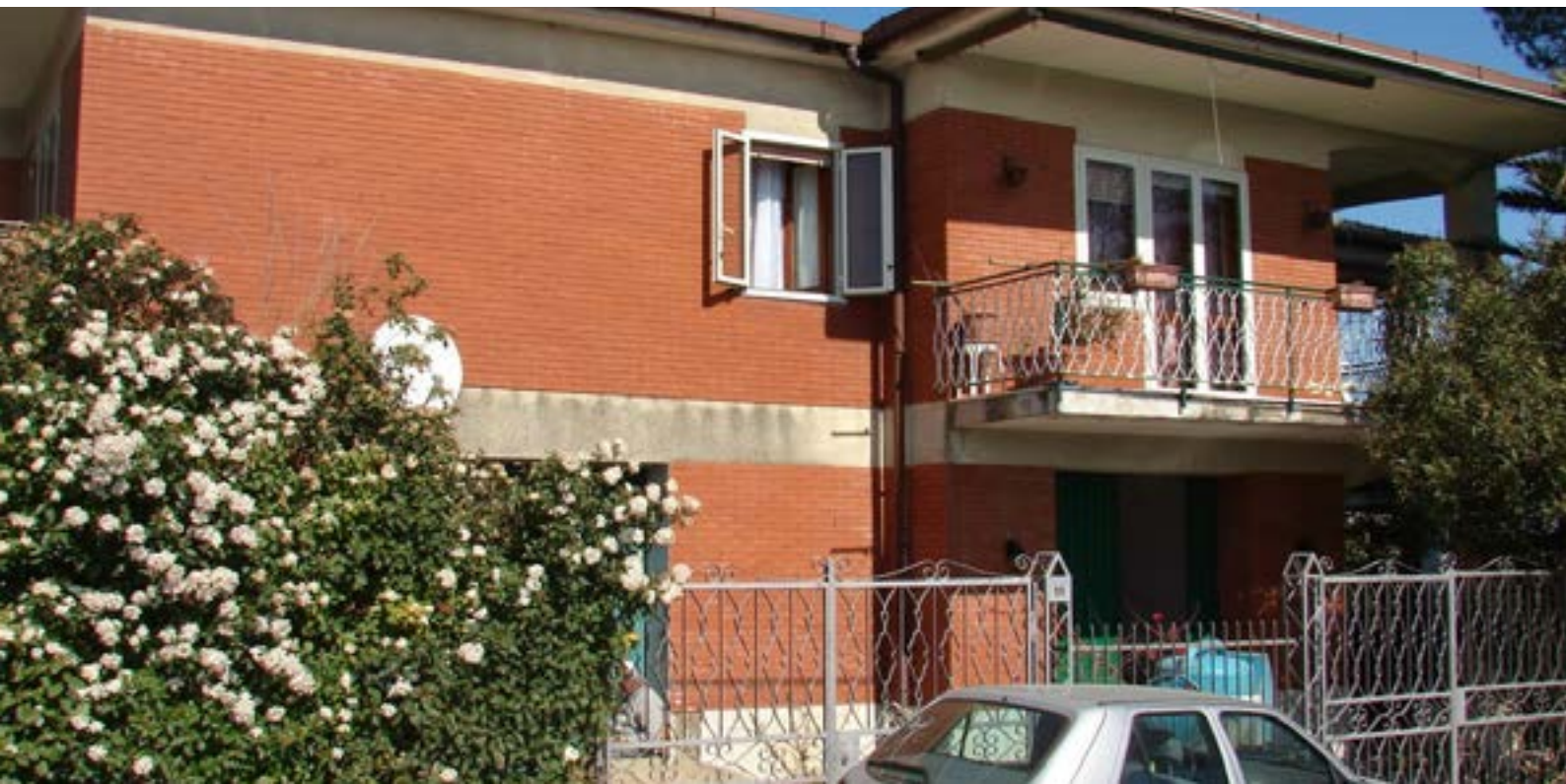
La villa prima dell'intervento
