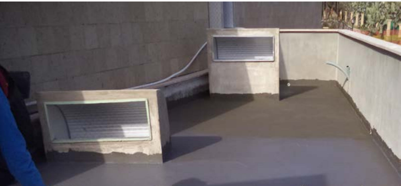
Impermeabilizzazione delle terrazze
