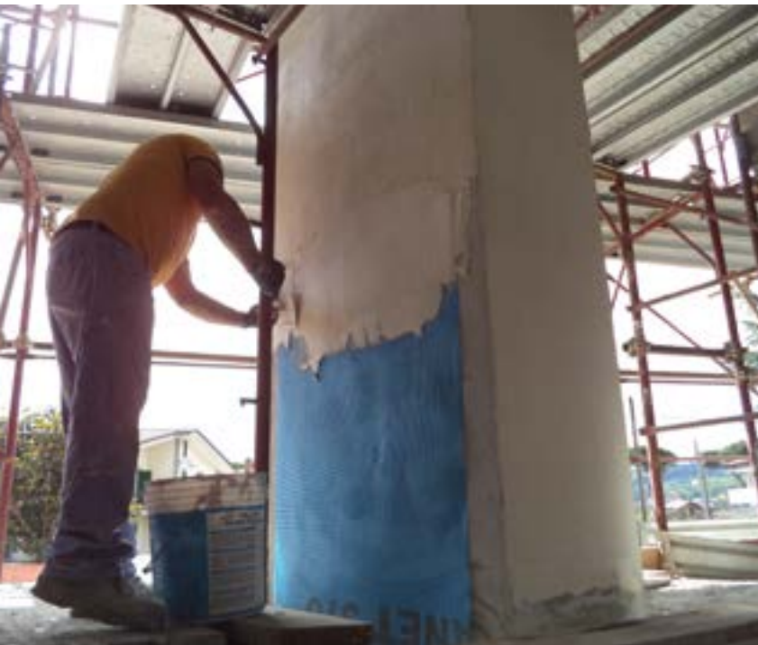
Sopra: applicazione di A 64 R-EVOLUTION , sotto: finitura ottenuta con RX 561
