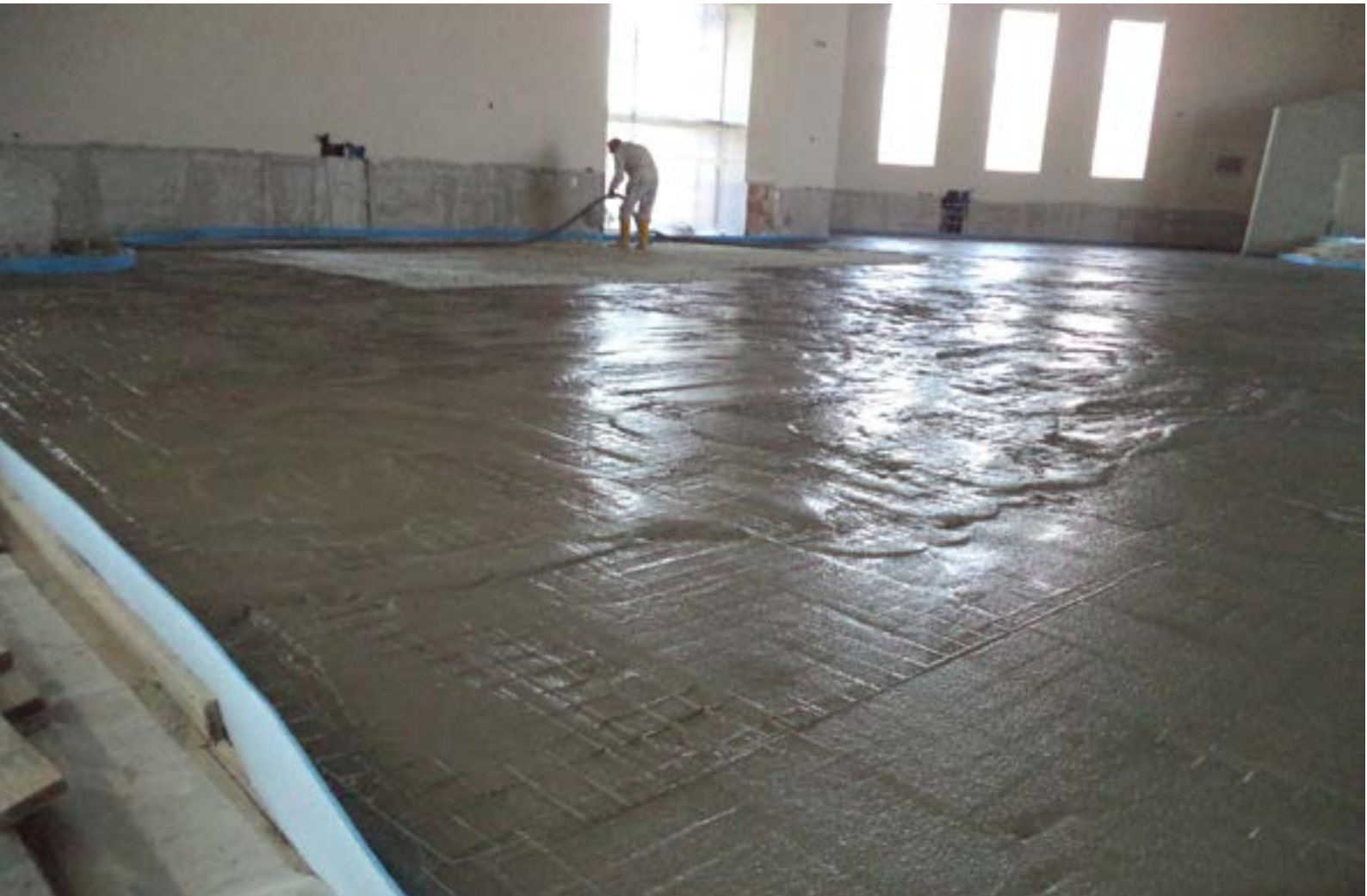
Applicazione del massetto SA 500
