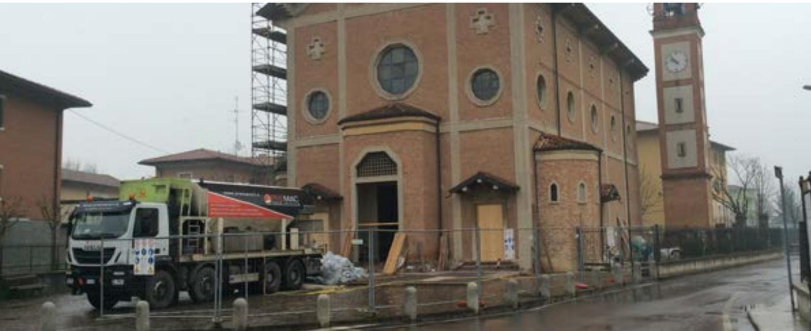
Camion della ditta Premac S.r.l. fornendo il massetto autolivellante SA 500
