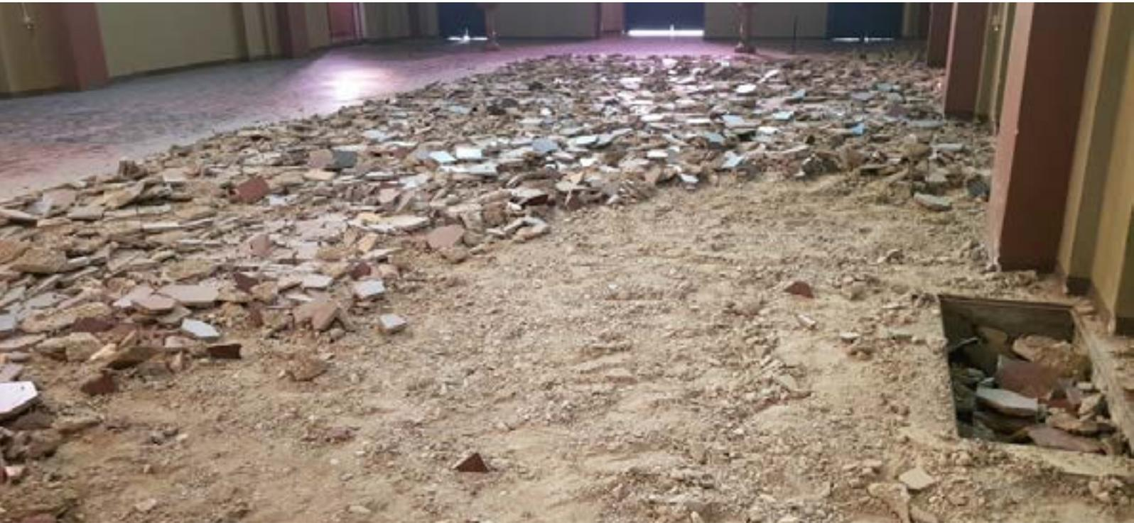
*Demolizione della pavimentazione esistente*
