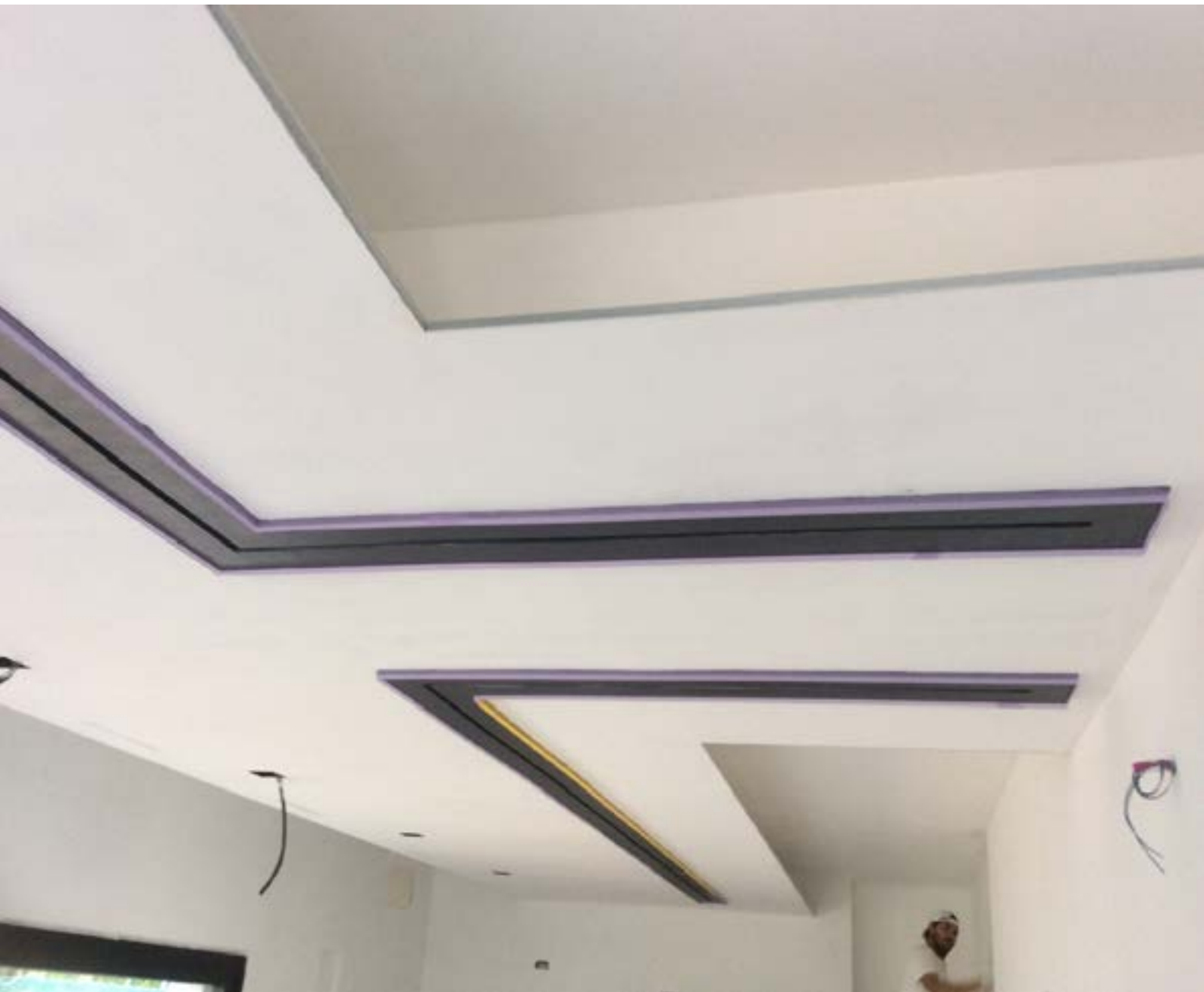
Realizzazione di controsoffitti con GYPSOTECH® STD TIPO A
