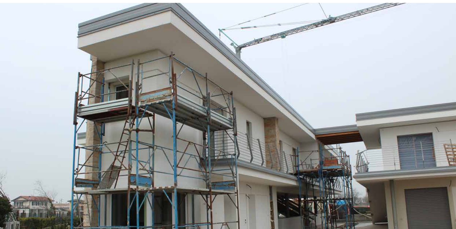
Applicazione dei pannelli di isolamento termico e rasatura finale
