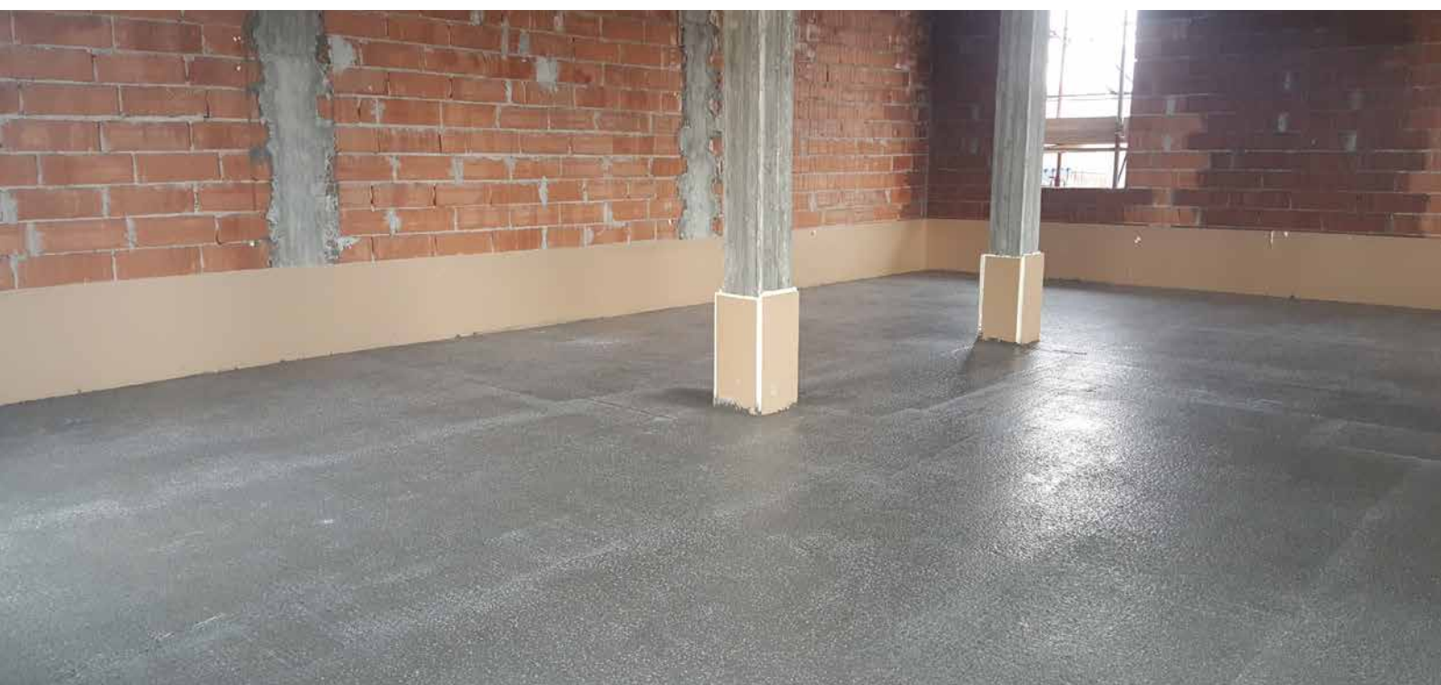
Realizzazione del piano sottoterra (sopra) e dei massetti (sotto)
