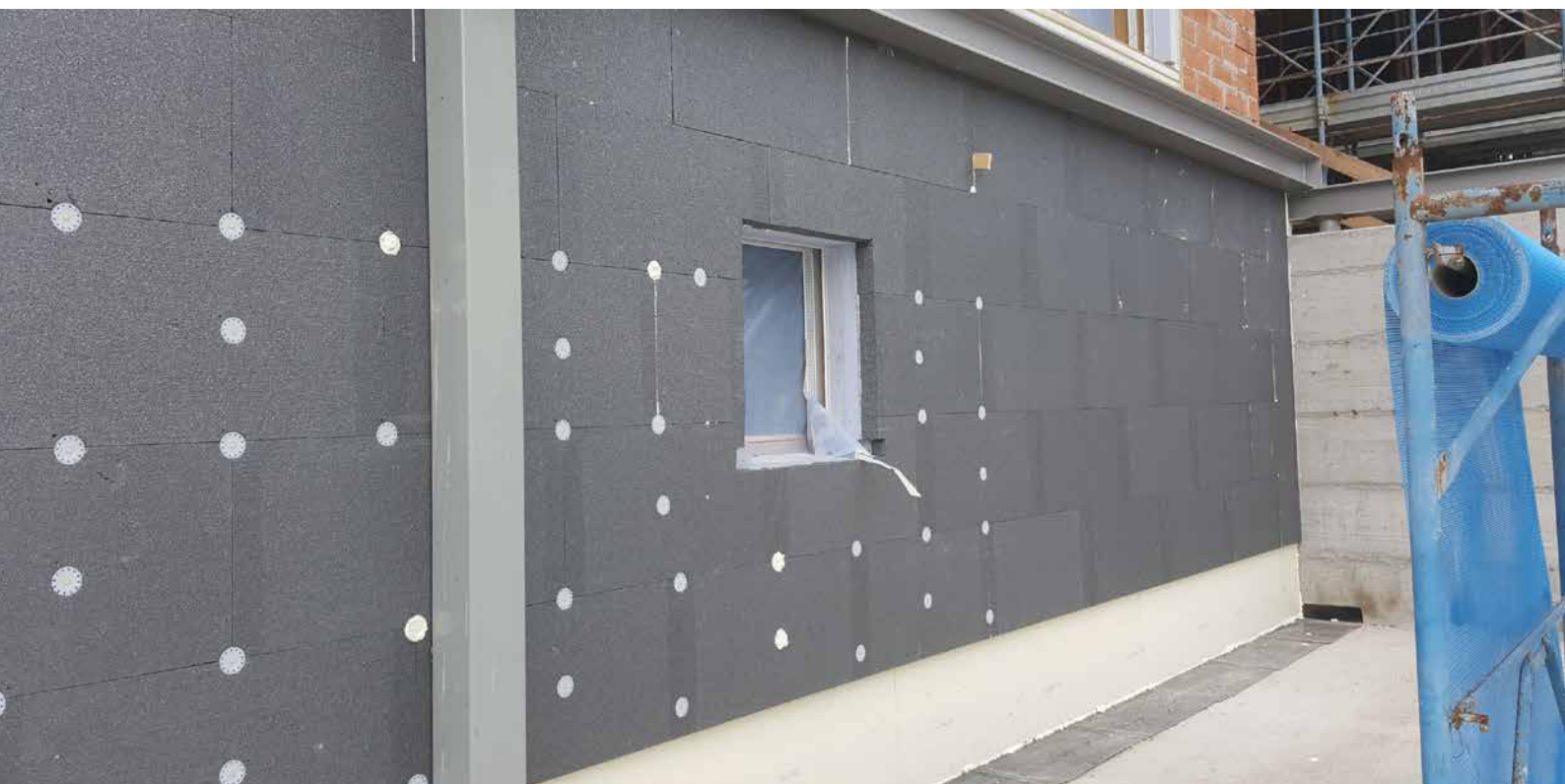
Applicazione dei pannelli di isolamento termico e rasatura finale
