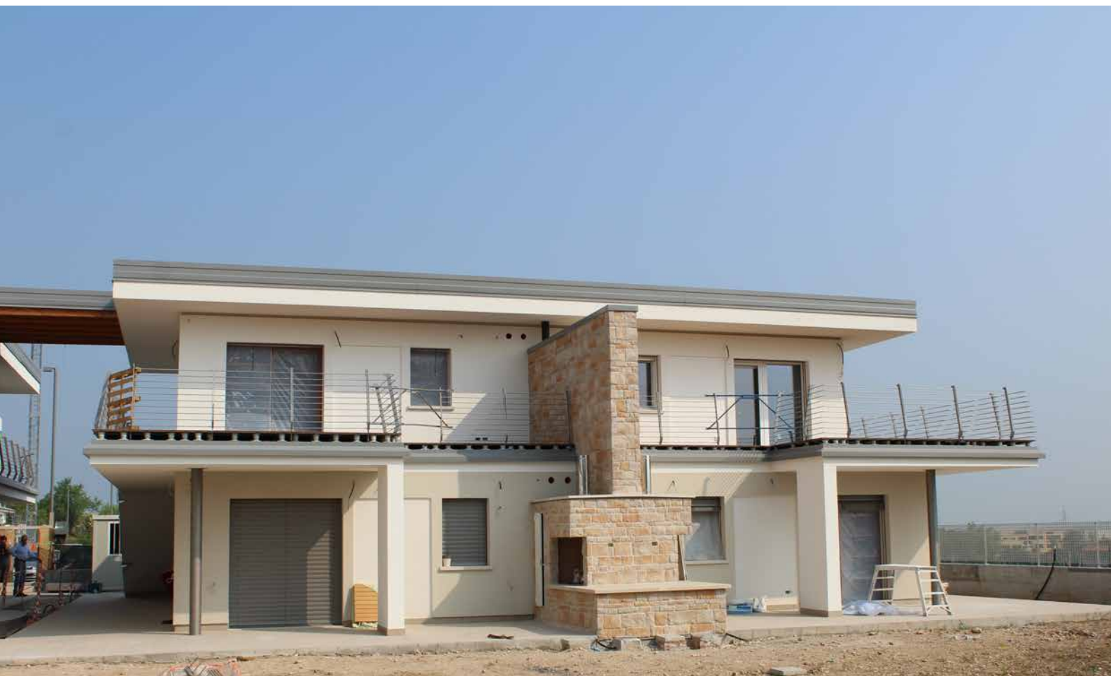
Vista posteriore della palazzina Est
