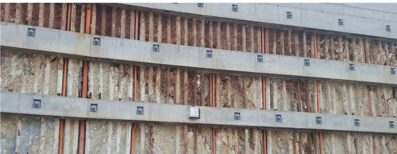
Dettaglio della paratia e dei tiranti
