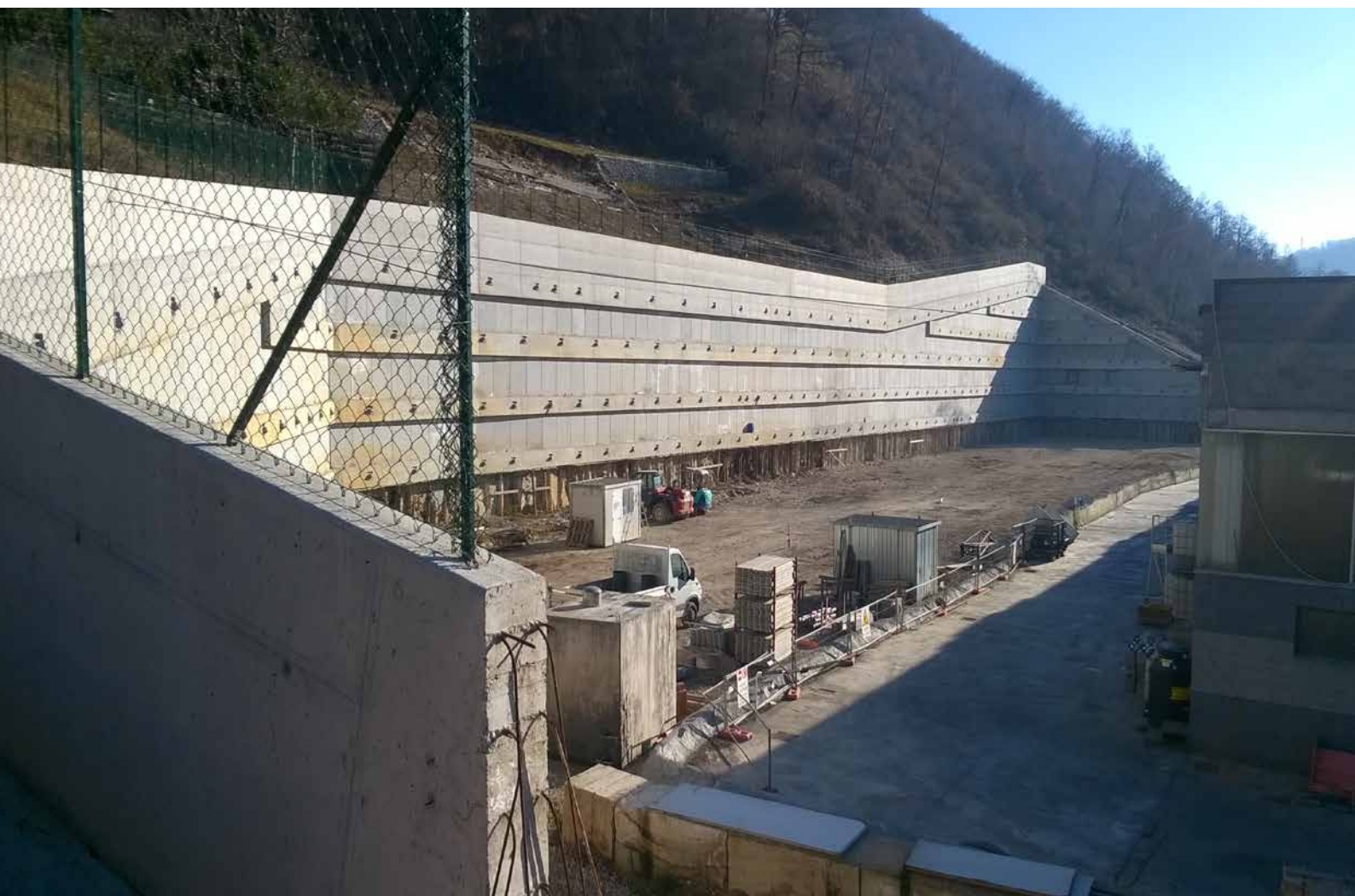
Tamponatura con lastre prefabbricate e riempimento delle cavità con BETONCINO RS 30
