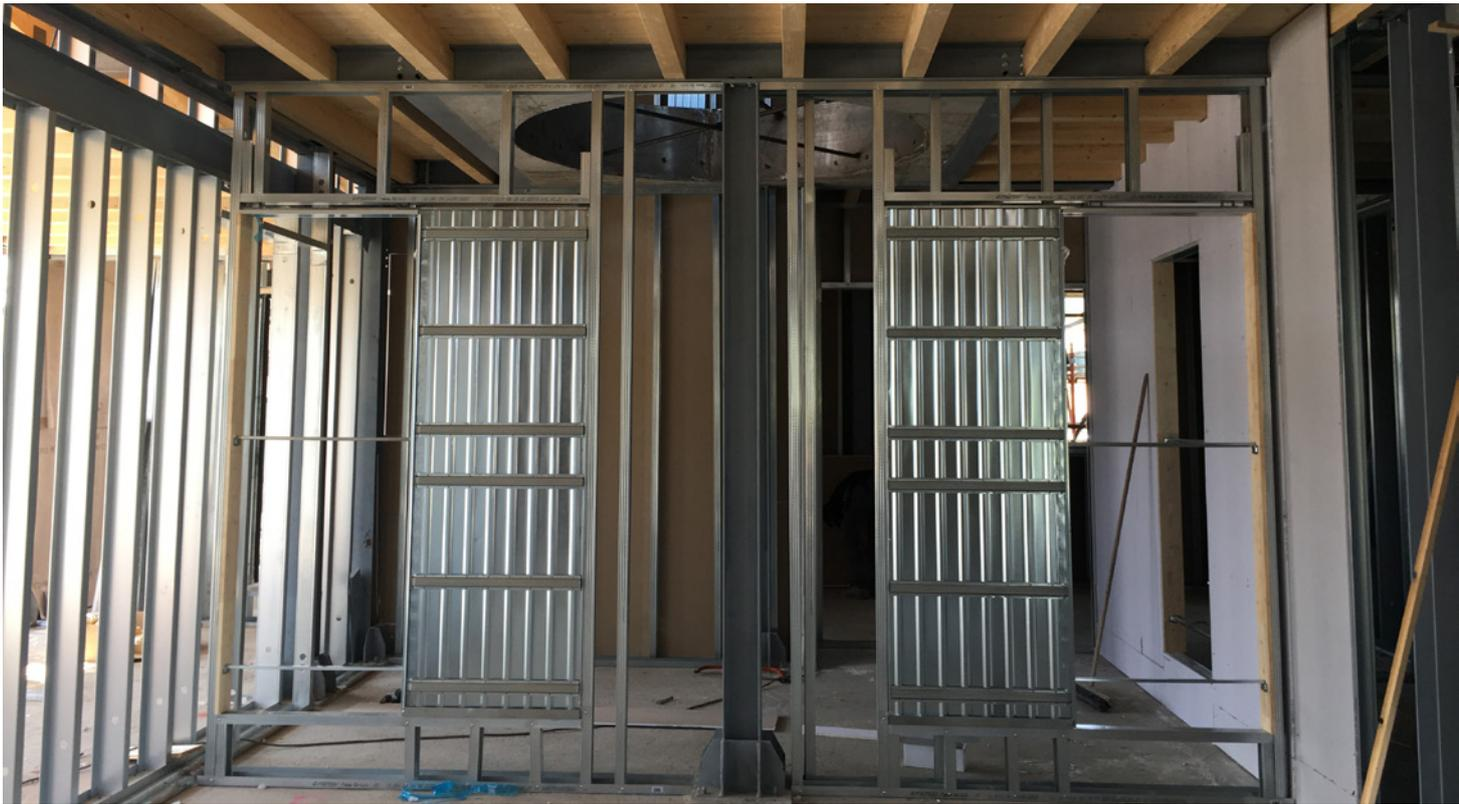
Sopra: applicazione di guide e montanti in zinco di magnesio per la successiva posa delle lastre di cartongesso.
