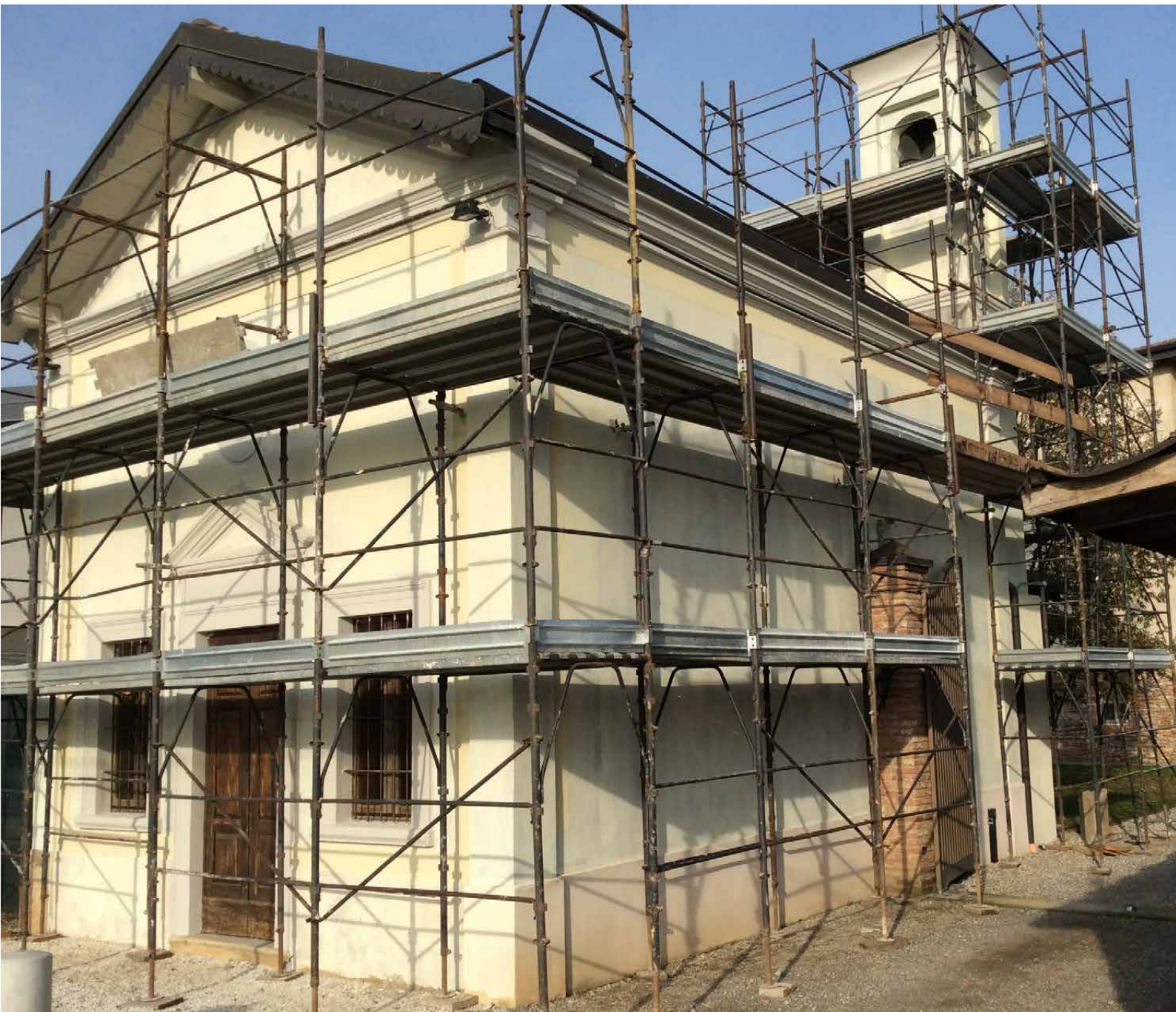
Le superfici esterne dopo la pulizia e applicazione dei prodotti Fassa Bortolo
