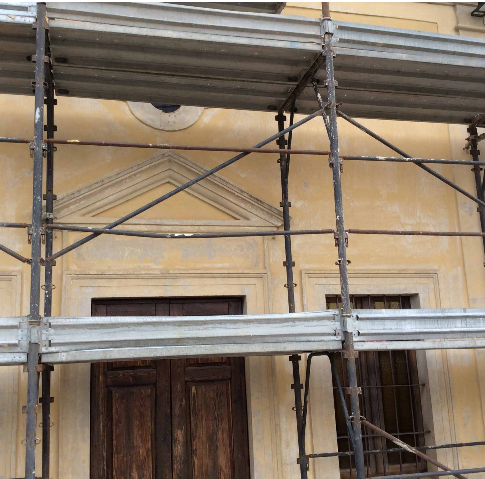
Lo stato della facciata principale prima dell'intervento
