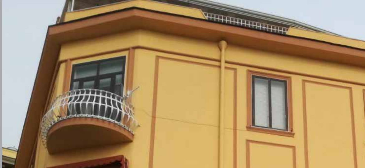
Rifacimento di facciate
