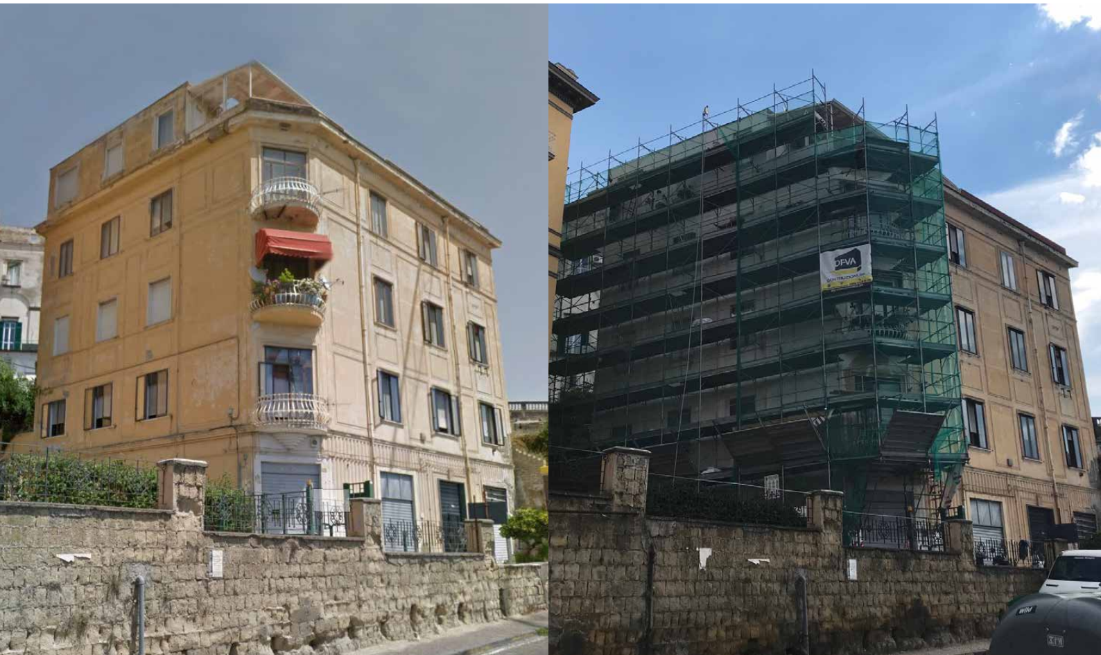
Lo stato dell'immobile prima dell'intervento e l'inizio delle opere di ripristino
