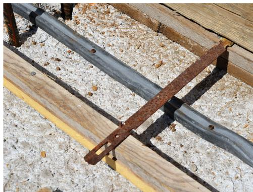
Evitare durante la posa di AQUAZIP JOINT qualsiasi situazione che possa generare uno schiacciamento del giunto bentonitico o impedisca il suo regolare confinamento da parte del getto di calcestruzzo.
