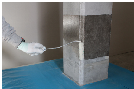
Phase 1: Behandlung mit FASSA EPOXY 100, wo erforderlich
