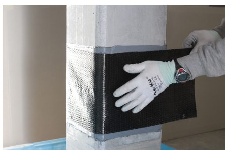
Phase 5: Positionierung von FASSATEX CARBON UNI 300 / 600
