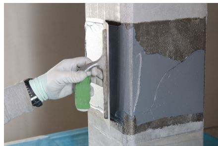
Phase 2: Ausgleich mit FASSA EPOXY 400
