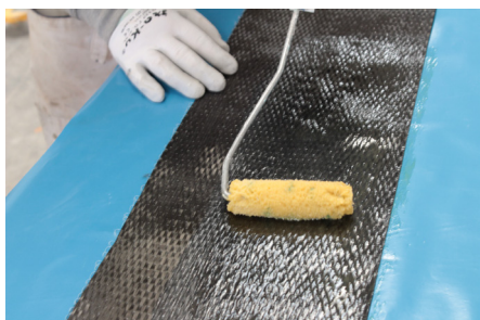
Phase 3: Vorimprägnierung mit FASSA EPOXY 200
