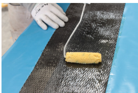
Fase 3: Pre-impregnazione con FASSA EPOXY 200
