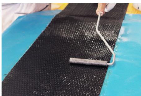
Fase 4: Omogeneizzazione dell'impregnante
