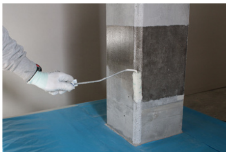
Fase 1: Trattamento con FASSA EPOXY 100, ove necessario
