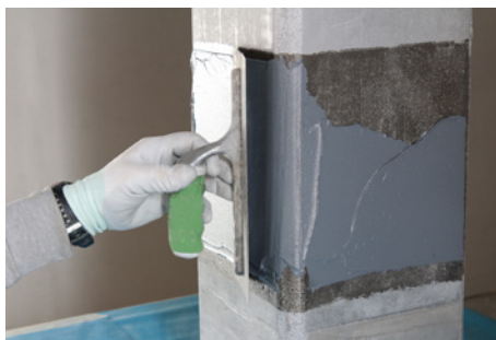
Fase 2: Regolarizzazione con FASSA EPOXY 400
