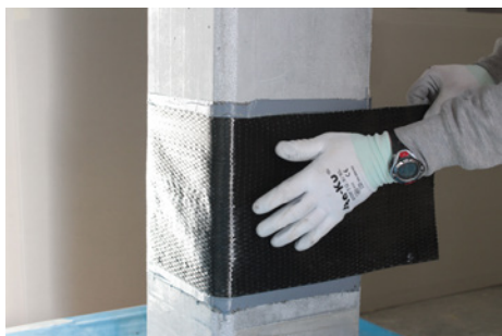
Fase 5: Posizionamento di FASSATEX CARBON UNI 300 / 600
