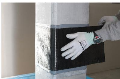
**Fase 5:** *Posizionamento di FASSTEX CARBON UNI 300 / 301 / 600*
