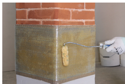
Phase 6: Imprägnierung mit FASSA EPOXY 200
