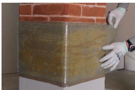
Phase 5: Positionierung von FASSATEX GLASS 300
