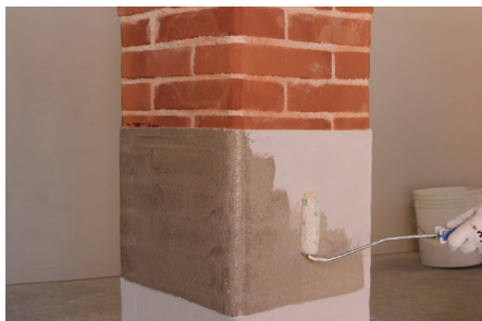
Phase 1: Behandlung mit FASSA EPOXY 100, wo erforderlich
