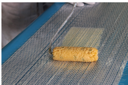
Phase 3: Vorimprägnierung mit FASSA EPOXY 200
