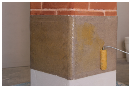
Phase 2: Anwendung von FASSA EPOXY 200
