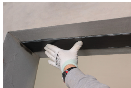
Phase 6: Positionierung von FASSAPLATE CARBON
