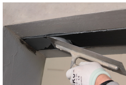
Phase 8: Auftragung von FASSA EPOXY 400 auf die Lamelle
