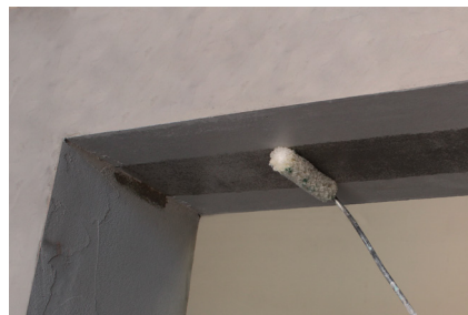
Phase 2: Behandlung mit FASSA EPOXY 100, wo erforderlich
