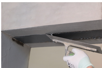
Fase 3: Regolarizzazione con FASSA EPOXY 400
