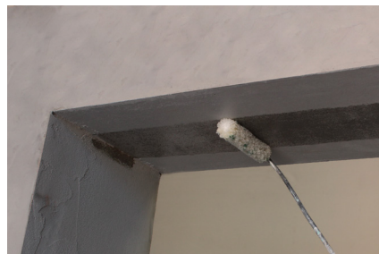
Fase 2: Trattamento con FASSA EPOXY 100, ove necessario
