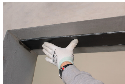
Fase 6: Posizionamento di FASSAPLATE CARBON
