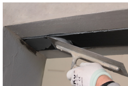
Fase 8: Applicazione di FASSA EPOXY 400 sulla lamina
