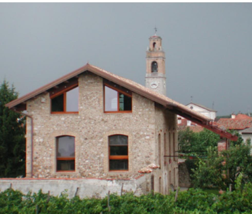
La stessa malta è stata utilizzata anche per la costruzione di un nuovo muro di pietra all'interno dell'edificio. Tenendo conto delle precarie condizioni dello stabile, il recupero è stato radicale per tutti i muri perimetrali, per la copertura e per il solaio di piano.
