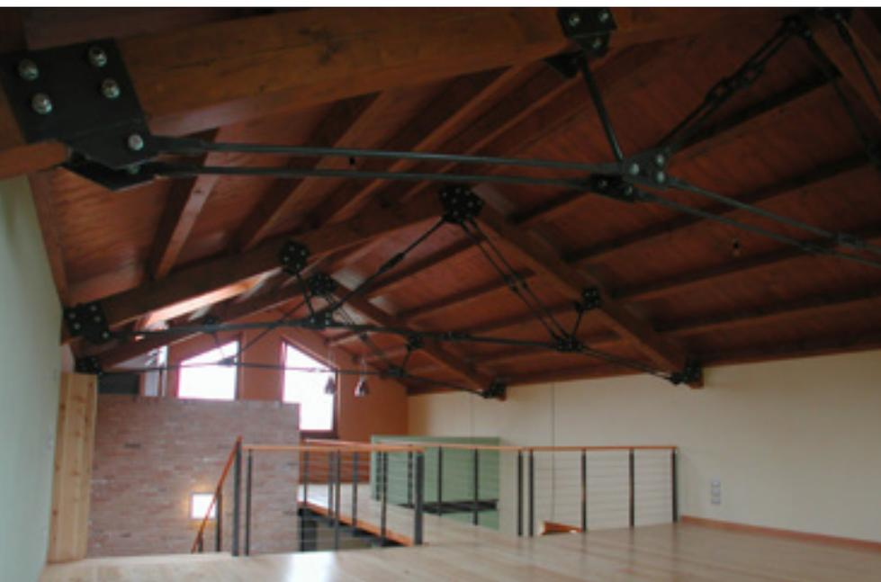
Il progetto, realizzato con materiali di recupero nuovi ma biocompatibili, ha previsto la conservazione e il consolidamento della muratura perimetrale con interventi di cucitura e tirantatura e la rincaffatura delle malte dove ritenuto necessario con **MB 60**.
