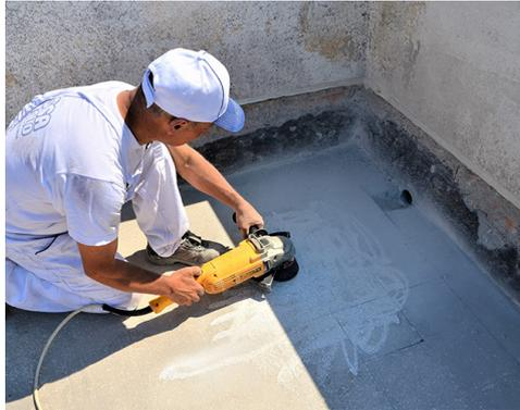
Es wird davon abgeraten, den Altboden mittels Druckwasserwäsche reinigen zu wollen, da dieser Vorgang dem darunterliegenden Untergrund zusätzliches Wasser zuführt.
