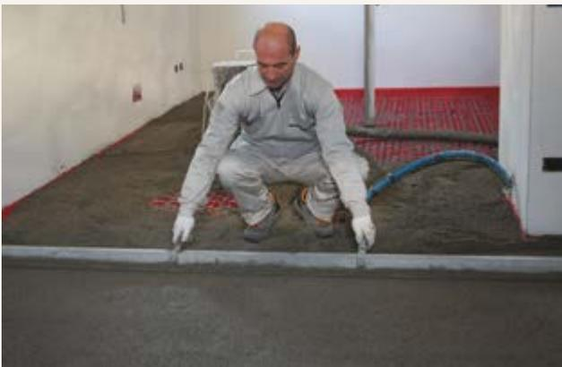
**Verbundestrich:** Entlang der Umfassungswände und um aufsteigende Elemente herum ist ein Randdämmstreifen aus komprimierbarem Material von 0,5 bis 1 cm Dicke anzubringen und eine Zementschlämme als Haftvermittler aufzustreichen; diese Schlämme erhält man durch das Anmischen von **FASSACEM** mit Latex **AG 15 FASSA**, verdünnt mit Wasser im Verhältnis 1:3.
