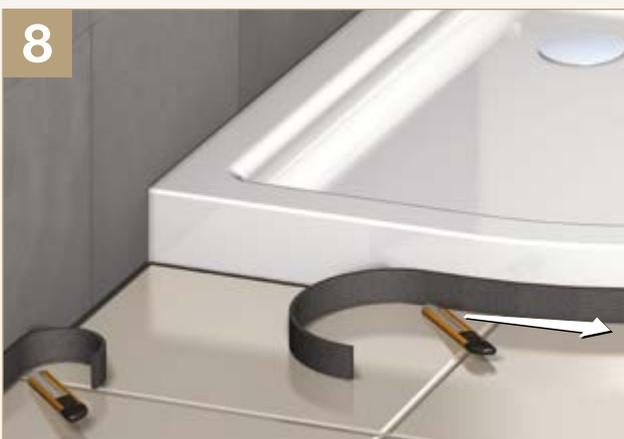
SILENS GP 1 erst nach dem Verlegen der Fußbodenbeläge abtrennen, um zu verhindern, dass der Bodenbelag mit irgendeinem vertikalen Bauelement in Kontakt kommen kann.
