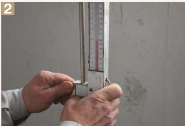
Um die Planebene des Aufbaus zu gewährleisten, sind entsprechende Niveaulinien und Eindämmungsstreifen einzusetzen. Es ist ratsam, im Bereich von Wandöffnungen oder eventuellen Vorsprüngen eine Trennscheidewand schon während der Verlegung einzufügen oder den bereits erhärteten Estrich einzuschneiden. Die Obergrenze für Flächen ohne Unterteilung liegt bei ca. 40 m<sup>2</sup>.
