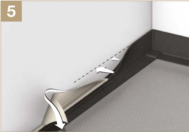
Nun auch die restliche Schutzfolie, jene auf der breiteren Seite, vom Streifen abziehen und diesen an die Wandfläche kleben. Dabei ist besonders auf die Eck- und Kantenausbildung zu achten: Der Klebstoff muss perfekt mit der Wandfläche verkleben, um die darauffolgende Verlegung des Fußbodenbelags zu erleichtern.
