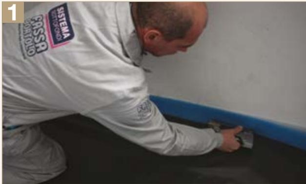
In Ermangelung besonderer Vorgaben auf der gesamten, herzustellenden Fläche eine geeignete, nicht saugende Trennschicht verlegen, die als Dampfbremse dient. Dabei die Stöße um mindestens 10 bis 15 cm überlappen und an der Wand umbiegen. Entlang der Umfassungswände und um aufsteigende Elemente herum ist ein Randdämmstreifen von 0,5 bis 1 cm Dicke anzubringen, der mindestens Estrichhöhe haben muss.
