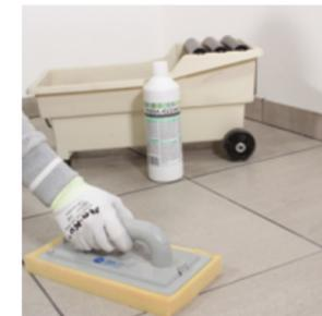
**1.** Fugen und Belag (Keramik, Marmor usw.) müssen präventiv von Kleberresten, Staub und losen Teilen durch sorgfältiges Absaugen gereinigt werden; darüber hinaus müssen die Fugen zu mindestens 2/3 der Fliesenstärke leer sein (die volle Fliesenstärke bei dünn-schichtigen Fliesen).
