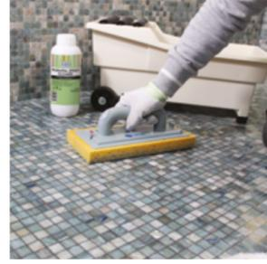
**1.** Fugen und Belag (Keramik, Glasmosaik usw.) müssen präventiv von Kleberresten, Staub und losen Teilen durch sorgfältiges Absaugen gereinigt werden; darüber hinaus müssen die Fugen zu mindestens 2/3 der Fliesenstärke leer sein (die volle Fliesenstärke bei dünn-schichtigen Fliesen).
