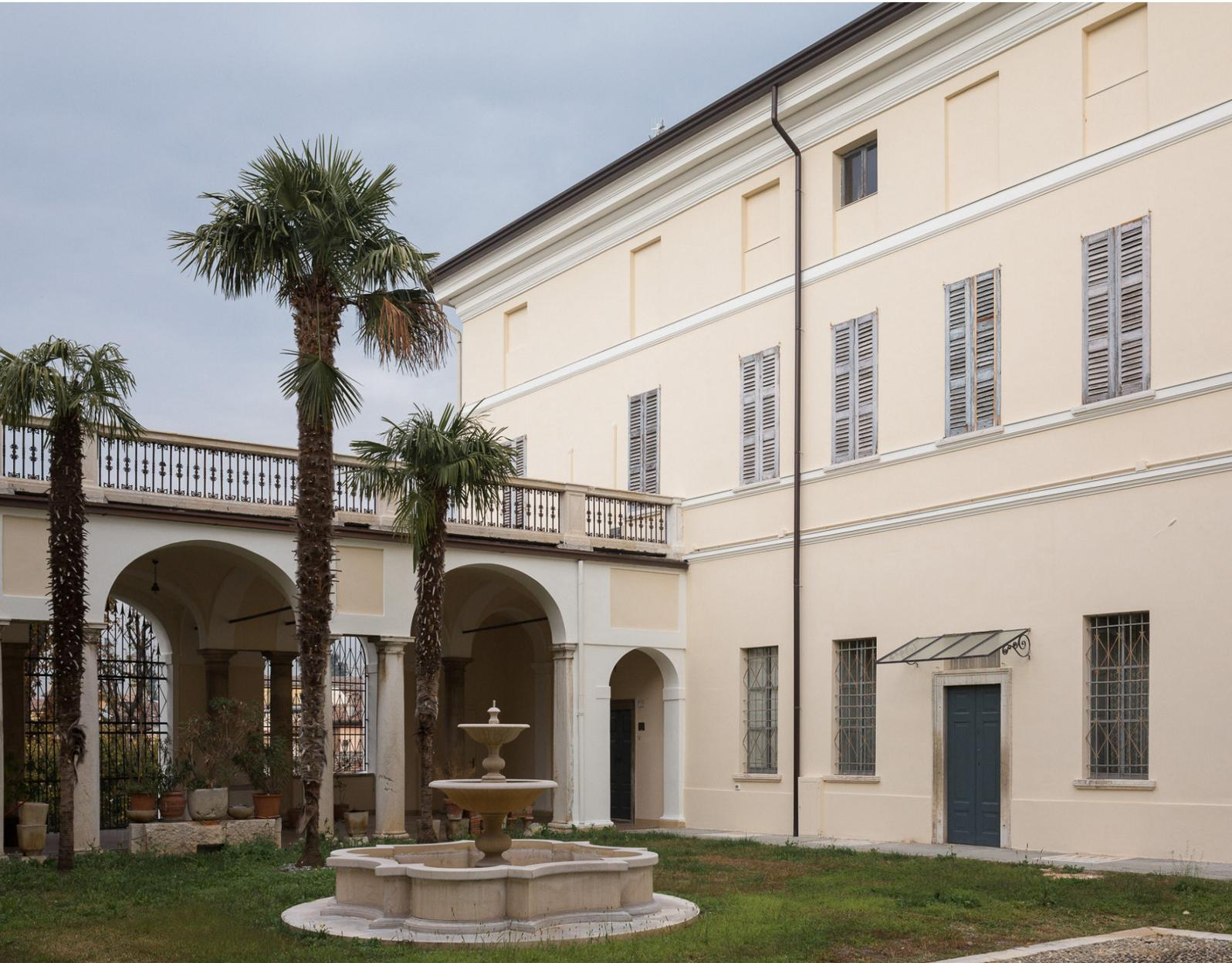
Ad asciugamento avvenuto è stata applicata su tutta la superficie della facciata l'idropittura minerale ai silicati liscia **FASSIL P 313** previa stesura del fondo fissativo ai silicati **FASSIL F 328**. La scelta della finitura è caduta sui prodotti della linea minerale ai silicati perché, grazie alle materie prime impiegate, permettono di proteggere adeguatamente gli intonaci di fondo mantenendo la traspirabilità delle murature.
