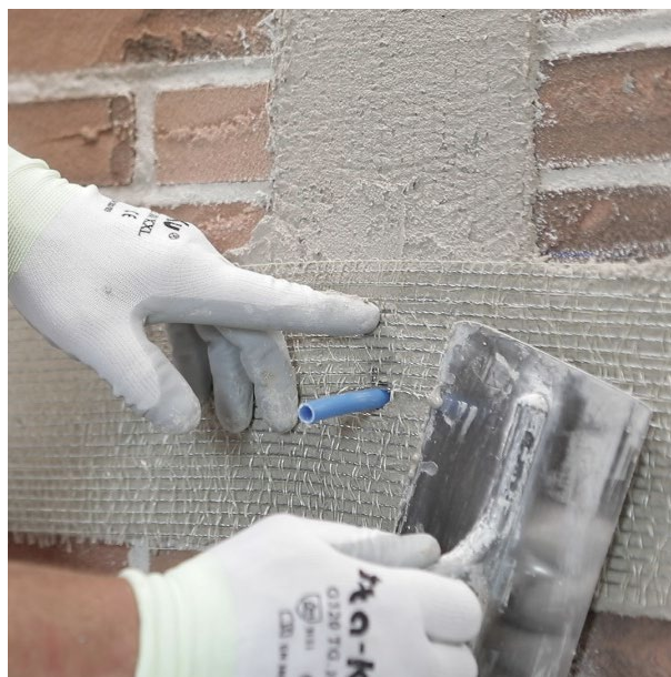
Figura 2 – Sistema FRCM di Fassa Bortolo con tessuto
