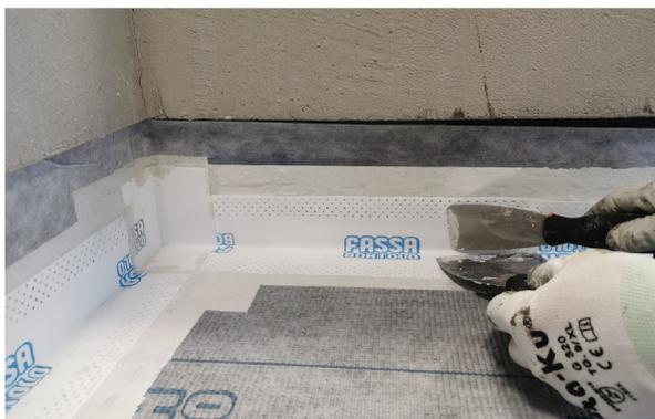
Die Behandlung aller kritischen Bereiche durch das Auftragen von AQUAZIP LAMINA FIX oberhalb des Zubehörs AQUAZIP ELASTOBAND zu mindestens 6 cm vervollständigen, 3 cm oberhalb des Zubehörteils und 3 cm oberhalb der Membran.
