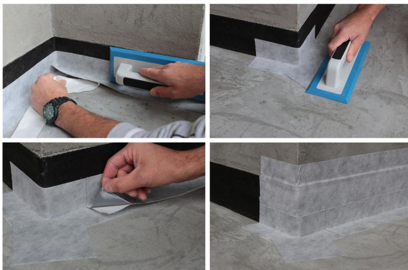
Dann AQUAZIP LAMINA 3D auf der zu behandelnden horizontalen Fläche mit dem zuvor bestimmten Klebstoff verkleben und darauf achten, dass selbiger auch oberhalb des Klebebands BANDELLA ADESIVA anhaftet (einen Fugenabstand zur Wandfläche von 5 mm einhalten); die Folie mit einem Dichtmasse-Roller anpressen; sich vergewissern, dass die Folie vollständig benetzt ist, und überschüssigen Kleber entfernen.
