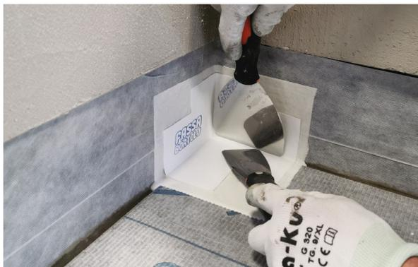
Nun alle Folienstöße mit dem Dichtband AQUAZIP ELASTOBAND versiegeln; den Spezial-Dichtkleber AQUAZIP LAMINA FIX mit der glatten Traufelseite entlang des gesamten Umfangs auftragen, sowohl auf die horizontale als auch auf die vertikale Fläche auf einem Abschnitt von etwa 10 cm Höhe. Den Dichtkleber auch im Bereich der zuvor eingebauten Zubehörteile im Umfeld von etwa 5 cm auftragen.
