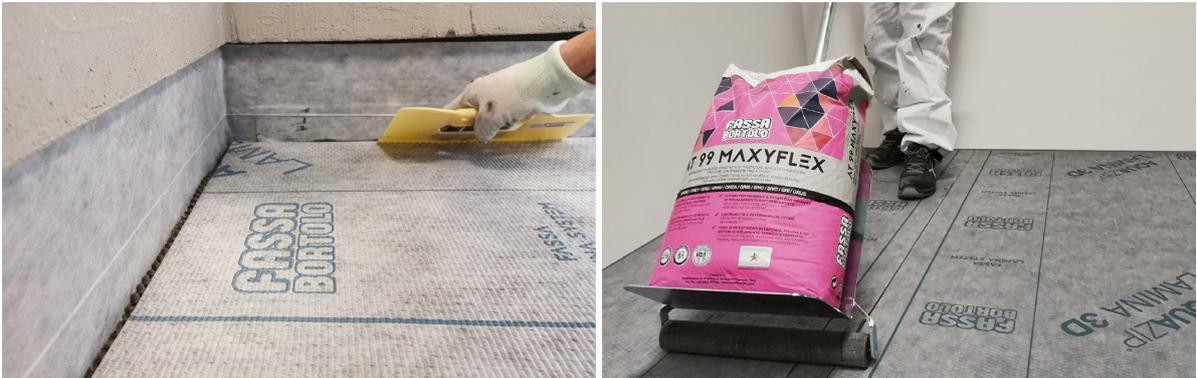
Die Klebermenge so regulieren, dass eine korrekte Benetzung der Folien erzielt wird; ein Überschuss an Klebstoff führt zur Bildung von Verkrustungen und Kräuselungen.
