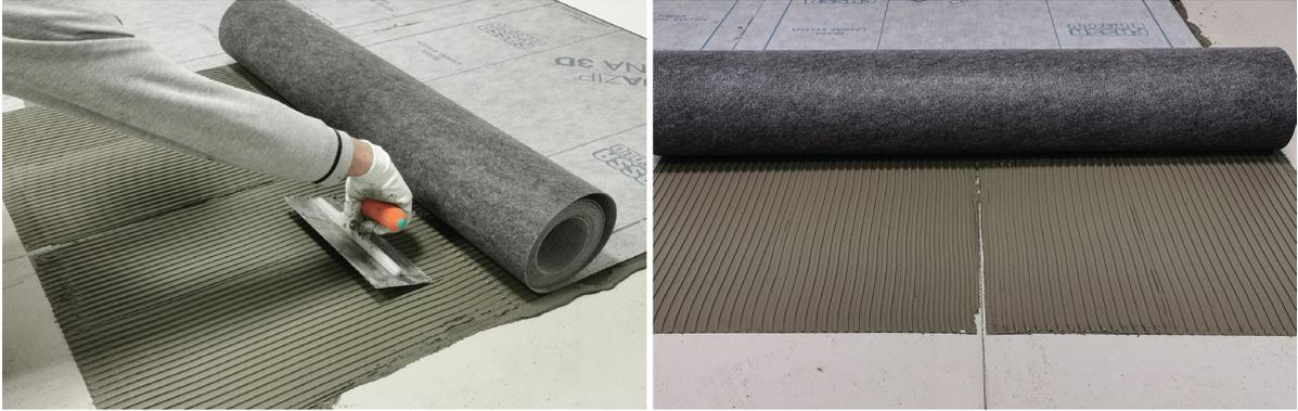
Die Folie mithilfe eines Dichtmasse-Rollers (ein Gewicht von etwa 10 kg verwenden), ausgehend von der Mitte nach außen, unmittelbar nach dem Auftragen in gleichmäßiger Form anpressen, um eventuell eingebundene Luftblasen vollständig zu eliminieren und gleichzeitig die Folie perfekt am Klebstoff anhaften zu lassen.
