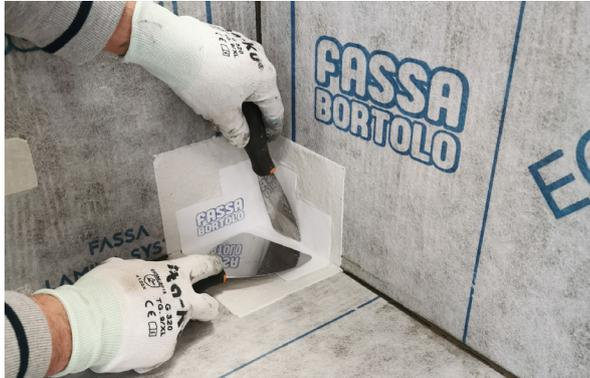
Nun alle Foliestöße mit dem Dichtband AQUAZIP ELASTOBAND versiegeln; den Spezial-Dichtkleber AQUAZIP LAMINA FIX mit der glatten Traufelseite entlang des gesamten Umfangs auftragen, sowohl auf die horizontale als auch auf die vertikale Fläche auf einem Abschnitt von etwa 10 cm; derselbe Vorgang ist im Übergangsbereich zwischen Wand- und Wandfläche auszuführen.
