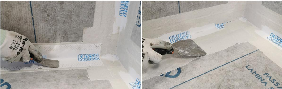
Auf den noch frischen Dichtkleber AQUAZIP LAMINA FIX das Dichtband AQUAZIP ELASTOBAND aufbringen und Druck ausüben, um eventuell eingebundene Luftblasen austreten und das Dichtband perfekt anhaften zu lassen; die Überlappung auf den Spezialteilen muss etwa 10 cm betragen, überschüssigen AQUAZIP LAMINA FIX entfernen.
