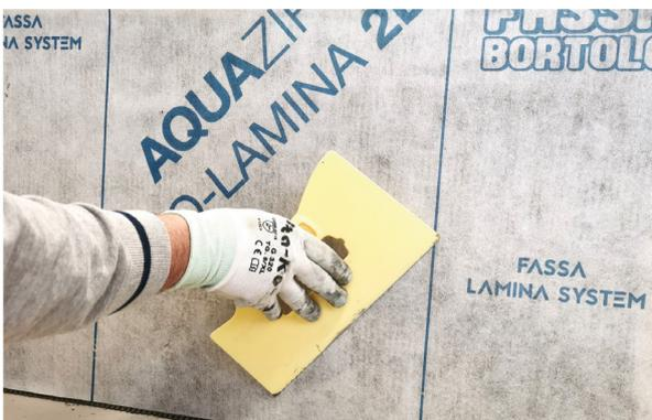
Mit dem Verlegen der verschiedenen Folien bis zur Abdeckung der gesamten vertikalen, zu realisierenden Fläche fortfahren; anschließend erfolgt die Behandlung der gesamten horizontalen Fläche, die Vorgangsweise ist dieselbe wie bei den Wandflächen.
