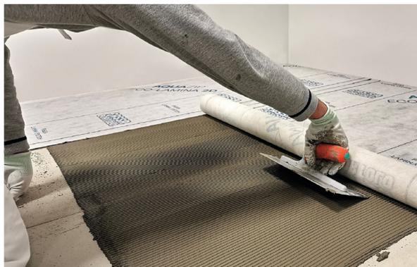
Mithilfe einer Plastiktraufel oder eines Plastikreibebretts (beide versehen mit abgerundeten Kanten, um die Folie nicht zu beschädigen) wird die Folie, beginnend von der Mitte nach außen, unmittelbar nach dem Verlegen angepresst, damit eventuell eingebundene Luftblasen austreten können und gleichzeitig die Folie perfekt am Klebstoff anhaften kann. Sich vergewissern, dass die Folie vollständig benetzt ist, und überschüssigen Kleber entfernen.
