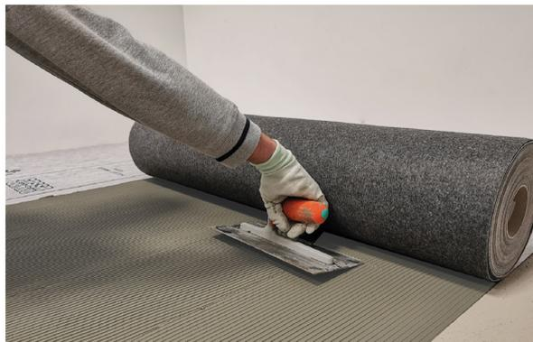
Die Folie mithilfe eine Dichtmasse-Rollers inmittelbar nach deren Auslegen von der Mitte ausgehend in gleichmäßiger Form anpressen, um eventuell eingebundene Luftblasen vollständig entweichen und die Folie gleichzeitig auf perfekte Weise am Klebstoff anhaften zu lassen.
