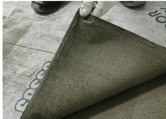
Die Klebermenge so regulieren, dass eine korrekte Benetzung der Folien erzielt wird; ein Überschuss an Klebstoff führt zur Bildung von Verkrustungen und Kräuselungen.
