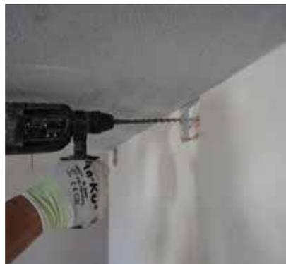
I tasselli vengono installati a rotazione mediante avvitatore.
