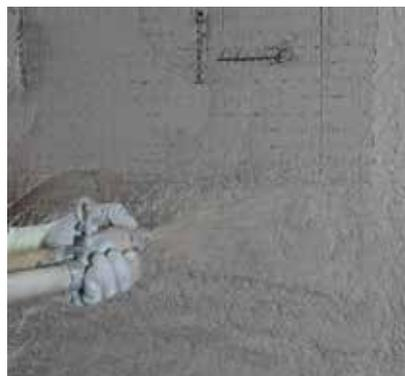
*Variante: qualora il progettista preveda le barre FASSA ELIWALL di diametro 10 mm, i prefori avranno diametro 8 o 9 mm in funzione della consistenza del supporto.*
