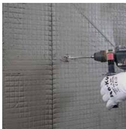
I prefori saranno realizzati con passo 50 cm e sfalsati tra due lati del paramento. Procedere quindi all'installazione delle barre **FASSA ELIWALL** nei prefori mediante l'impiego dell'apposito adattatore spingibarre montato su un trapano ad innesto SDS. Si consiglia di prevedere in corrispondenza delle barre fazzoletti ripartitori 10x10 cm ricavati dalla stessa rete **FASSANET ZR 185**.
