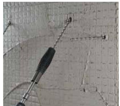
Terminata l'installazione delle barre, piegare la parte non infissa delle barre elicoidali (pari a 10-15 cm) mediante l'ausilio di un utensile piegaferro, fino a portarla in posizione di adiacenza con la rete.
