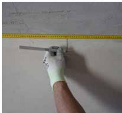
Nel caso di connessione perimetrale realizzata mediante le staffette **STAFFA PERIMETRALE**, eseguire delle tasche nell'intonaco esistente sulle murature perimetrali dove è prevista l'installazione delle stesse.
