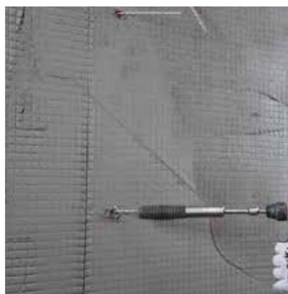
Terminata l'installazione delle barre, piegare la parte non infissa delle barre elicoidali (pari a 10-15 cm) mediante l'ausilio di un utensile piegaferro, fino a portarla in posizione di adiacenza con la rete.
