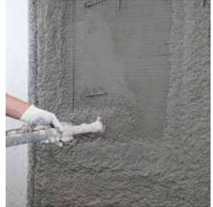
La lavorazione si completa con la staggiatura della superficie e la successiva rimozione delle imperfezioni superficiali mediante spatola di plastica.
