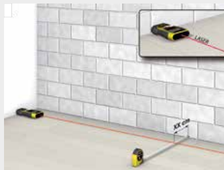
1. Tracciamento guida a pavimento
