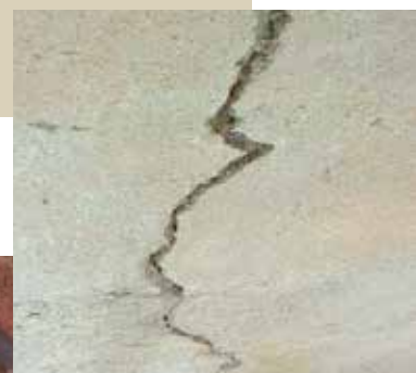
SPACCATURA DELL'INTONACO
