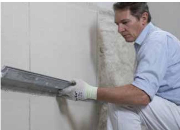
Dopo l'applicazione, **FASSA ONE DRY** si raddrizza con staggia ad H o a coltello con passaggi in senso orizzontale e verticale sino ad ottenere una superficie piana.
