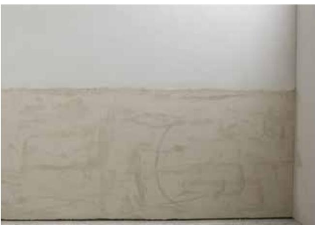
A completa maturazione di **FASSA ONE DRY**, l'intervento procede con l'applicazione di un intonaco di finitura traspirante a scelta tra S 605, BIO-INTONACO FINE, FINITURA 750 o FINITURA IDROFUGATA 756.
