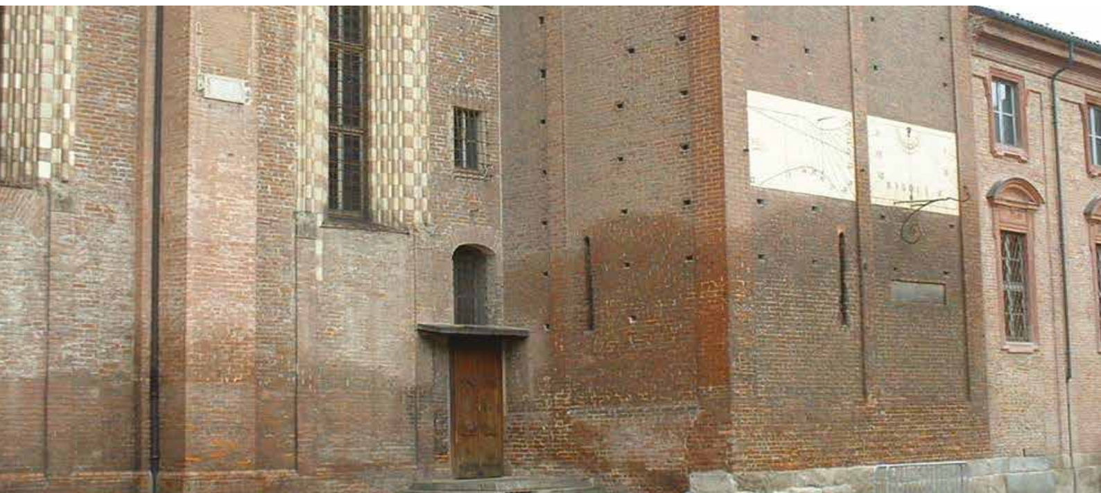
ESEMPIO DI RISALITA PER CAPILLARITÀ
