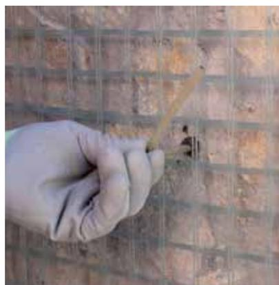
La rete dovrà risultare distanziata dalla muratura e più precisamente nella mezzeria dello spessore totale di malta e pari a 30-40 mm (considerato al netto del livellamento del supporto). Di conseguenza, si raccomanda di fissare la rete ai connettori mediante fascette in nylon, in modo tale da evitare spostamenti o deformazioni della stessa durante la fase di spruzzatura.
