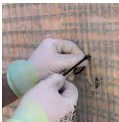
Nel caso del sistema **FASSANET SOLID MAXI SYSTEM**, prevedere l'utilizzo di fazzoletti di ripartizione in corrispondenza dei connettori **FASSA GLASS CONNECTOR L**. I fazzoletti, di dimensioni almeno 15x15 cm e ricavati dalla rete **FASSANET ARG SOLID**, saranno disposti diagonalmente rispetto alla direzione della rete.
