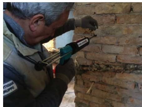
Ancoraggio nella muratura di CONNETTORI STRUTTURALI IN FIBRA
