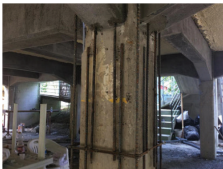
Ancoraggio chimico di BARRE METALLICHE
