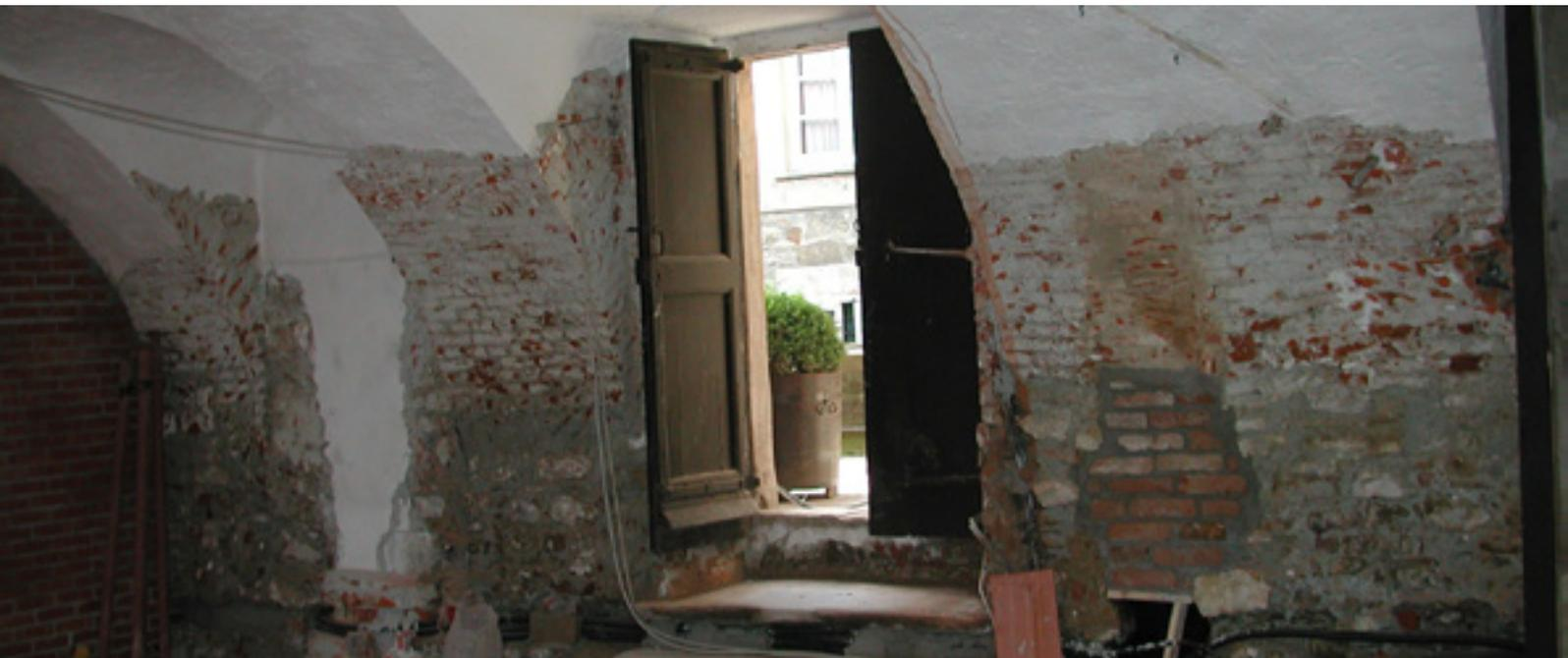
Come si nota nella foto di sinistra, alcune stanze, all'interno, necessitavano di un intervento di recupero radicale data la forte presenza di umidità. È stato così applicato l'intero sistema risanante: S 639, S 650 ed S 605.
