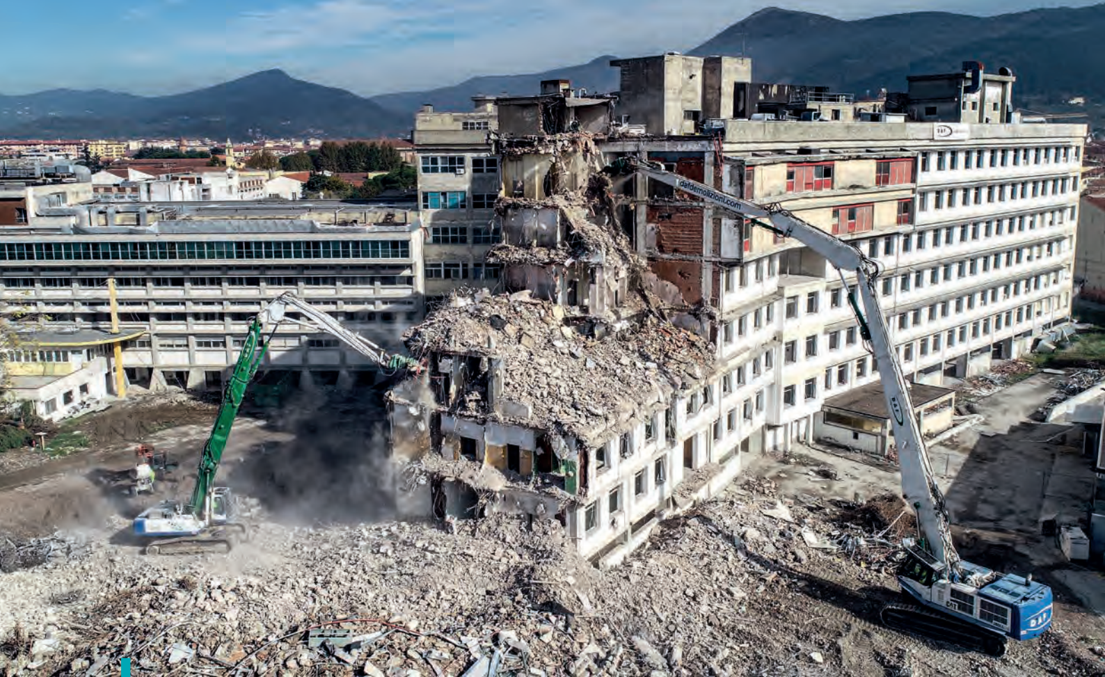
La demolizione selettiva del vecchio Ospedale di Prato
