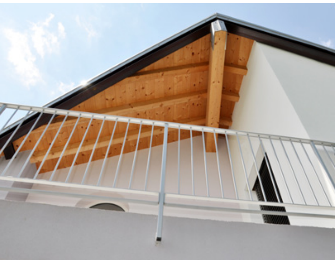
Balcone visto dall'esterno
