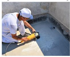
Es wird davon abgeraten, den Altboden mittels Druckwasserwäsche reinigen zu wollen, da dieser Vorgang dem darunterliegenden Untergrund zusätzliches Wasser zuführt.
