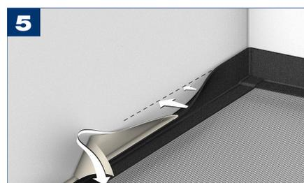
Stendere SILENS GP 1 in tutti i punti in elevazione della superficie in modo da realizzare la completa desolidarizzazione del successivo massetto dal resto della struttura. In tutti i punti in cui si è reso necessario tagliare SILENS GP 1, per poter creare la corretta angolatura, si deve ripristinare la continuità dell'isolante con il nastro SILENS NA 1.
