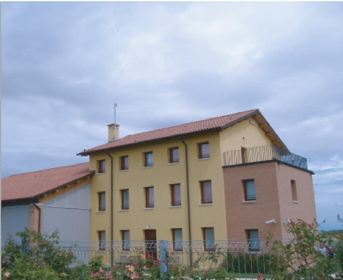
Al fine di incrementare l'isolamento termico dell'edificio è stato applicato il termointonaco KT 48. Il rifacimento delle parti basse dell'edificio, internamente ed esternamente, è stato eseguito con un intonaco specifico per zoccolature KZ 35. Infine, le murature in mattoni a facciavista sono state protette con idrorepellente silossanico IS 510.
