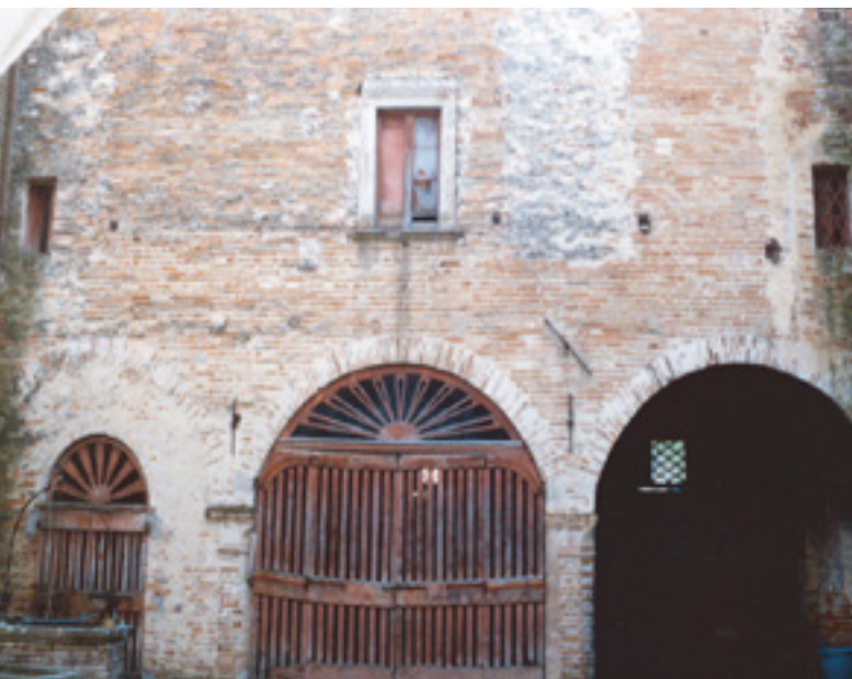
Vista prima dell'intervento di una delle pareti esterne dell'edificio
