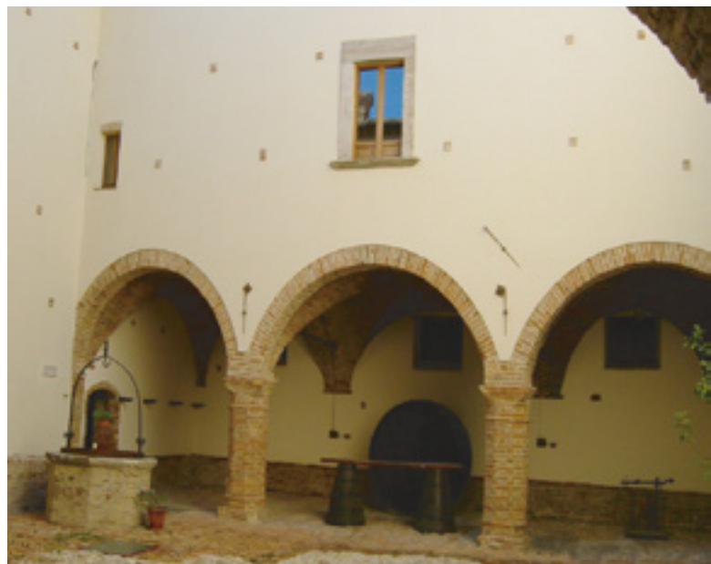
La stessa muratura dopo l'intervento
