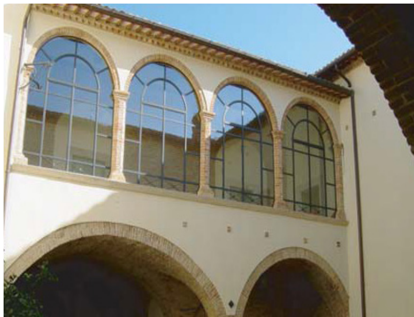
La stessa muratura dopo l'intervento
