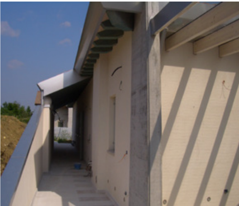
Particolare nei quali si vede la posa del rasante A 64
