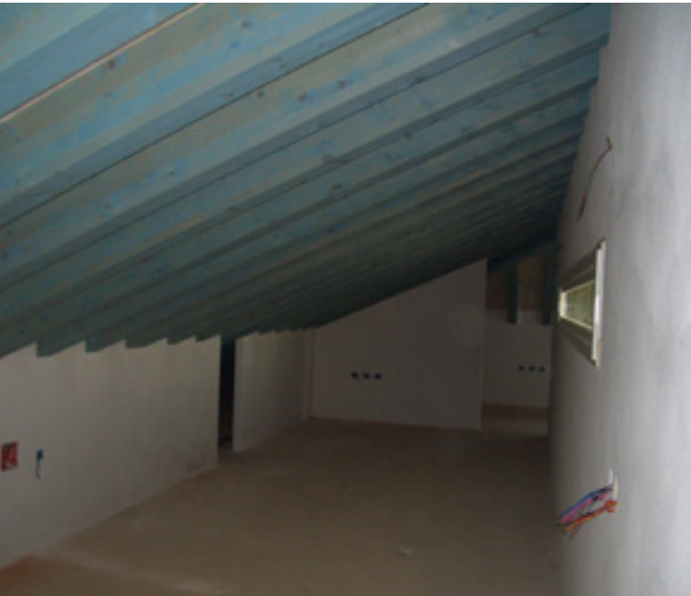
Particolari dell'interno dove è stato applicato il bio-intonaco KB 13 e il massetto autolivellante SA 500
