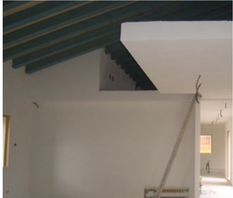
Particolari dell'interno dove è stato applicato il bio-intonaco KB 13 e il massetto autolivellante SA 500
