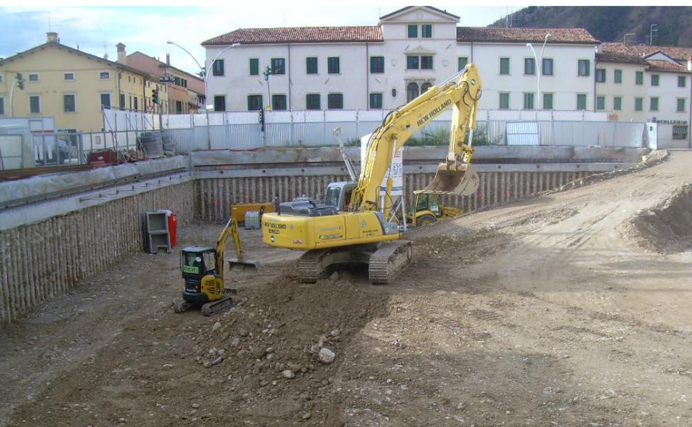
La piazza, sotto la quale sono stati realizzati i 107 posti auto costruiti su 2 piani, occupa una superficie di 2.400 mq. Per il consolidamento del terreno circostante sono stati impiegati due prodotti del **SISTEMA UNDERGROUND di FASSA BORTOLO**: la malta **SB 568** specifica per gunitaggio e il **BETONCINO RS 30**. Entrambi sono prodotti premiscelati a prestazioni garantite, forniti anche in silos, utilizzabili con appositi impianti di pompaggio.
